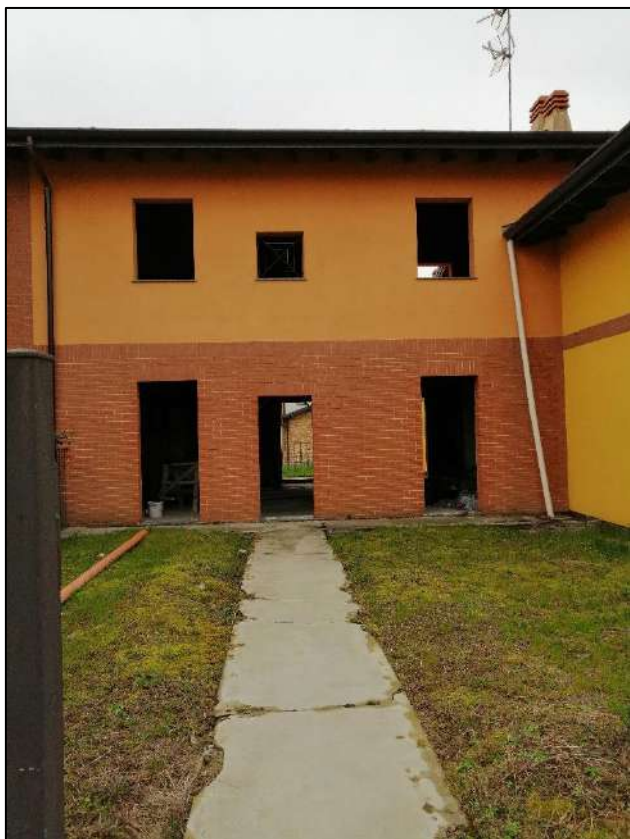
Vista accesso da vialetto interno
