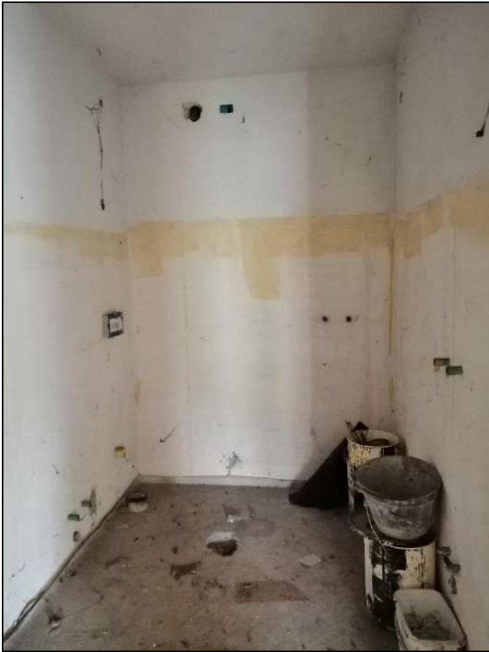
Piano terra - bagno
