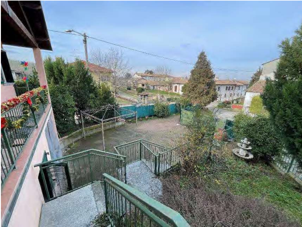
15. Piazzale pertinenziale e scala esterna.
