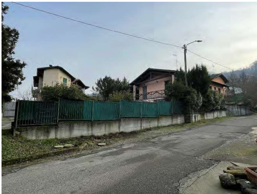
3. Recinzione del lotto sul lato nord-ovest dalla strada di Frazione Olesi.
