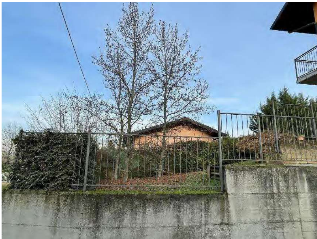
7. Lato sud del lotto.
