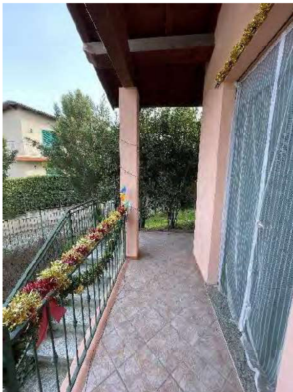
16. Balcone al piano primo.
