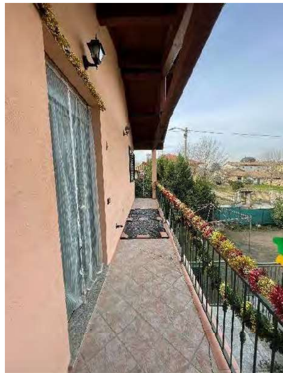
17. Balcone al piano primo.
