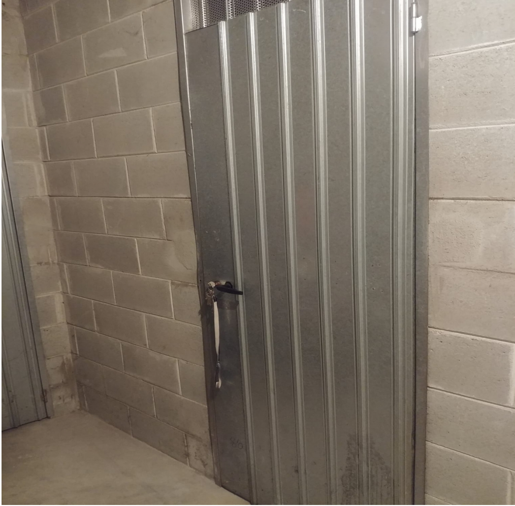
- Vista interna della porta della cantina -
