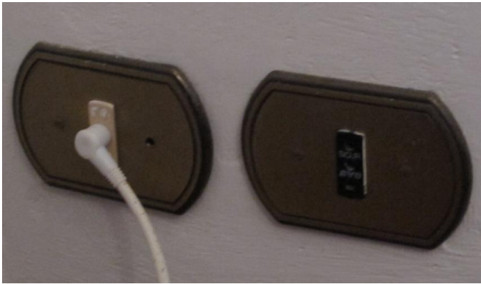
Fig. 4 e 5 – Prese antenna tv terrestre
