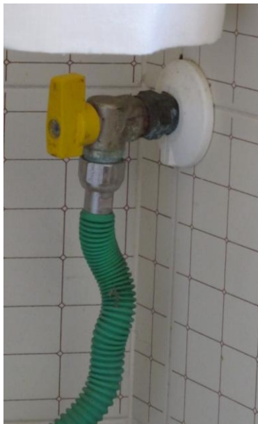
Fig. 20 e 21 – Rubinetto d'intercettazione gpl e collocazione contatore
