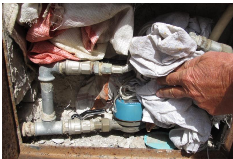
Fig. 15 – Contatore acquedotto
