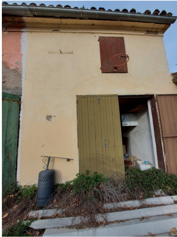
Fotografia E.3 - Garage
