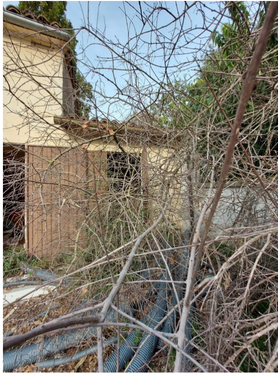
Fotografia E.7 - Lavanderia
