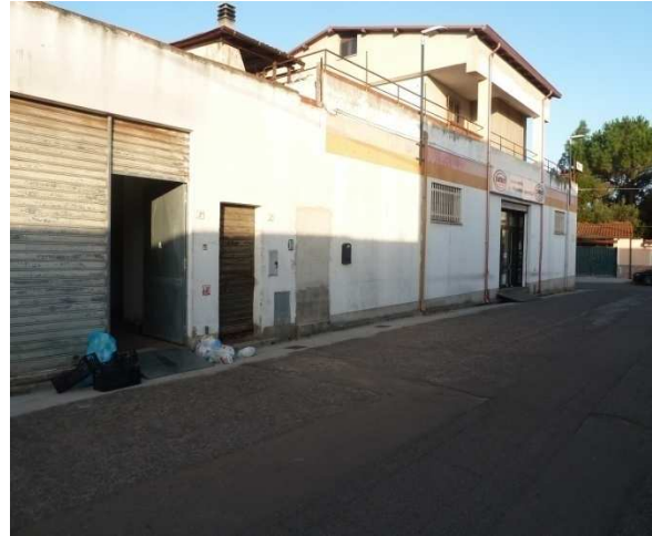
Foto n. 17 prospetto via G. Deledda
