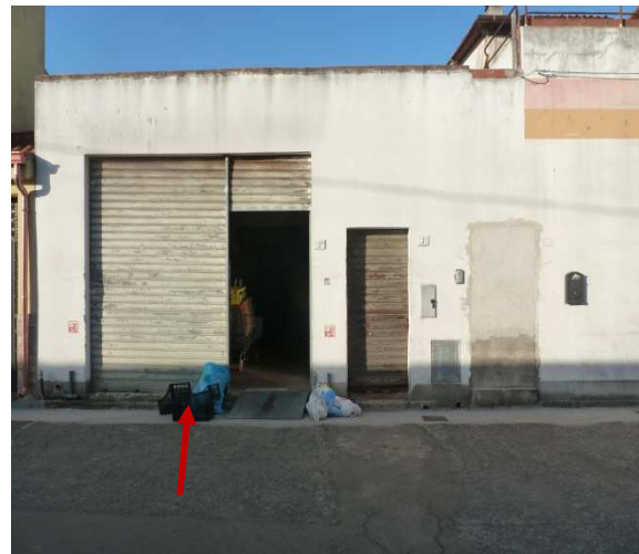
Foto n. 3 ingresso magazzino civico 2b
