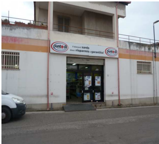
Foto n. 2 ingresso locale civico 2
