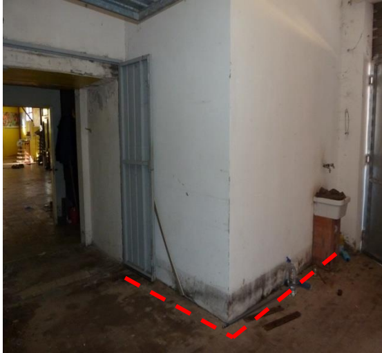
Foto n. 1 area in possesso sub 2
