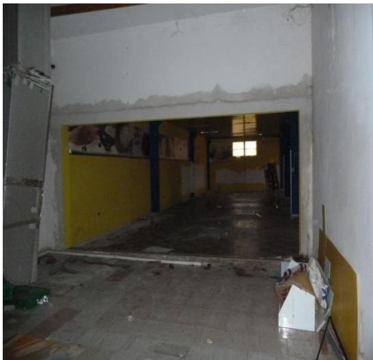
Foto n. 7 varco lato magazzino
