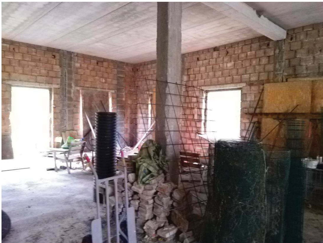
Foto 18. Locale deposito vista interna – piano terra (SUB.5)
