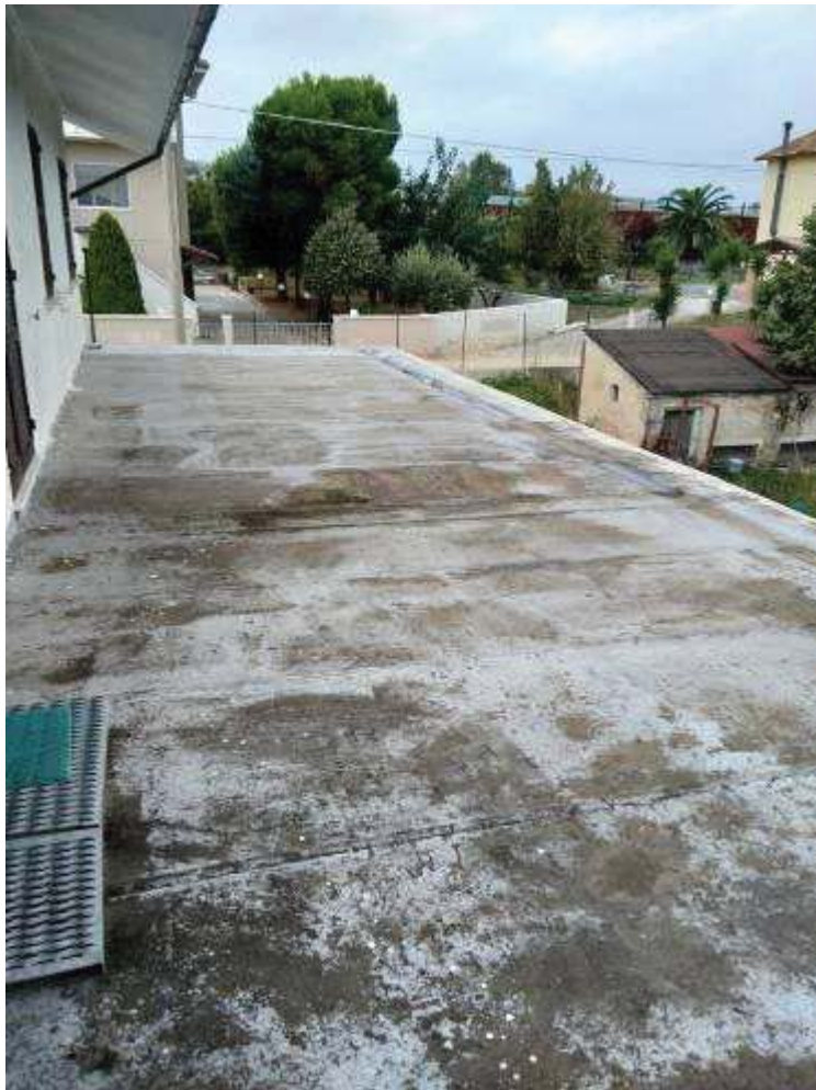
Foto 7. Terrazzo – U.I.2 piano primo
