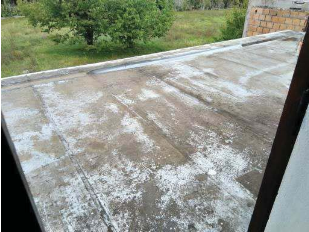
Foto 14. Terrazzo – U.I.3 piano primo
