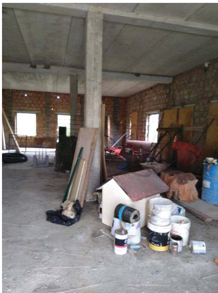
Foto 17. Locale deposito vista interna – piano terra (SUB.5)
