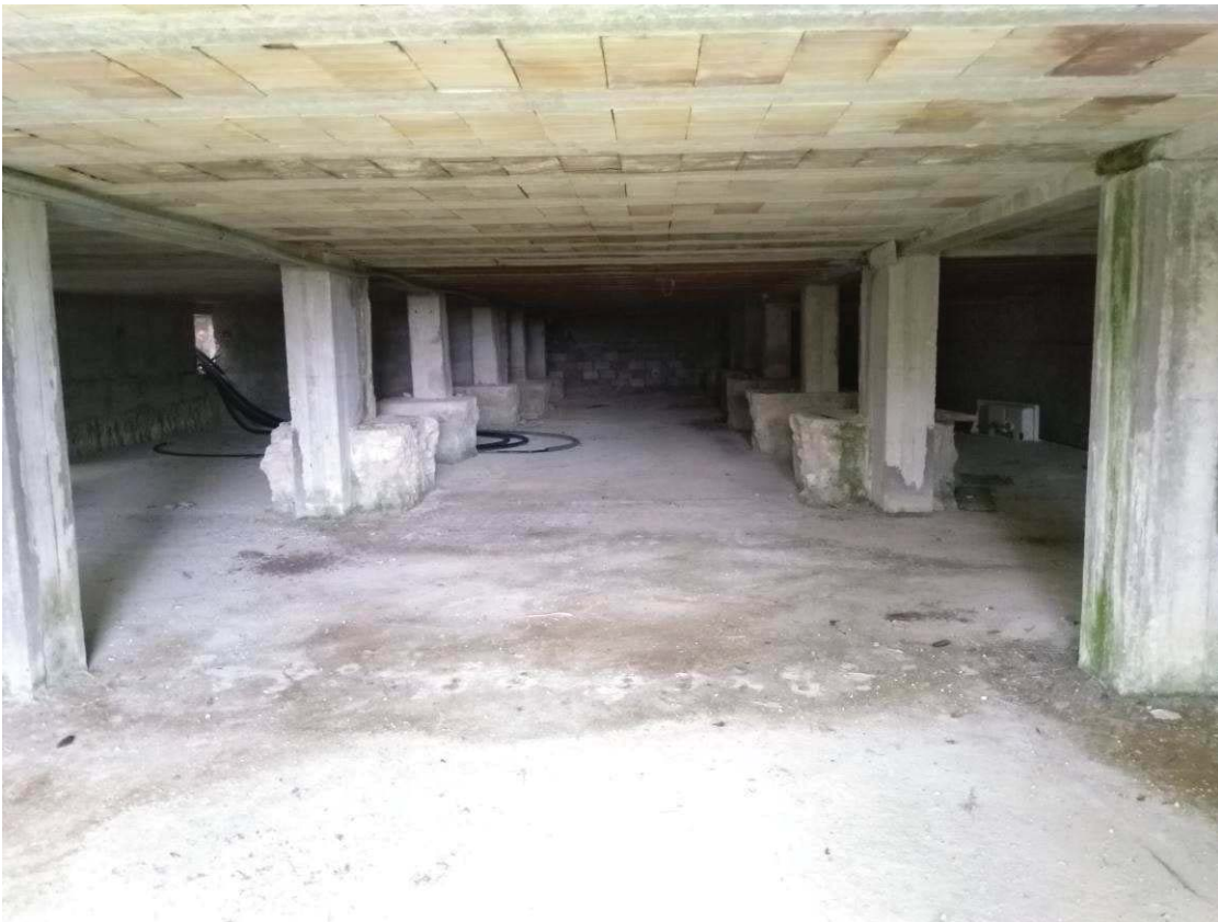
Foto 21. Locale deposito – piano interrato (SUB.2)
