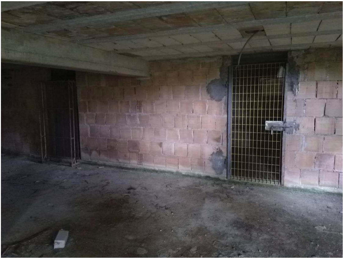
Foto 22. Locale deposito – piano interrato
