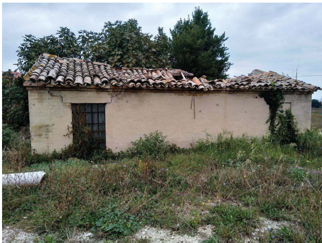
Foto 24. Locale garage – piano terra
