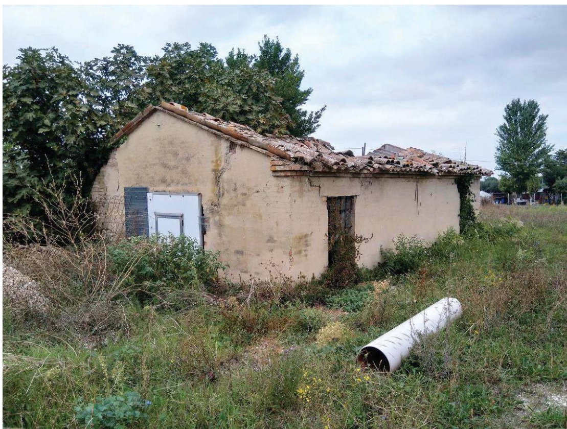
Foto 23. Locale garage – piano terra
