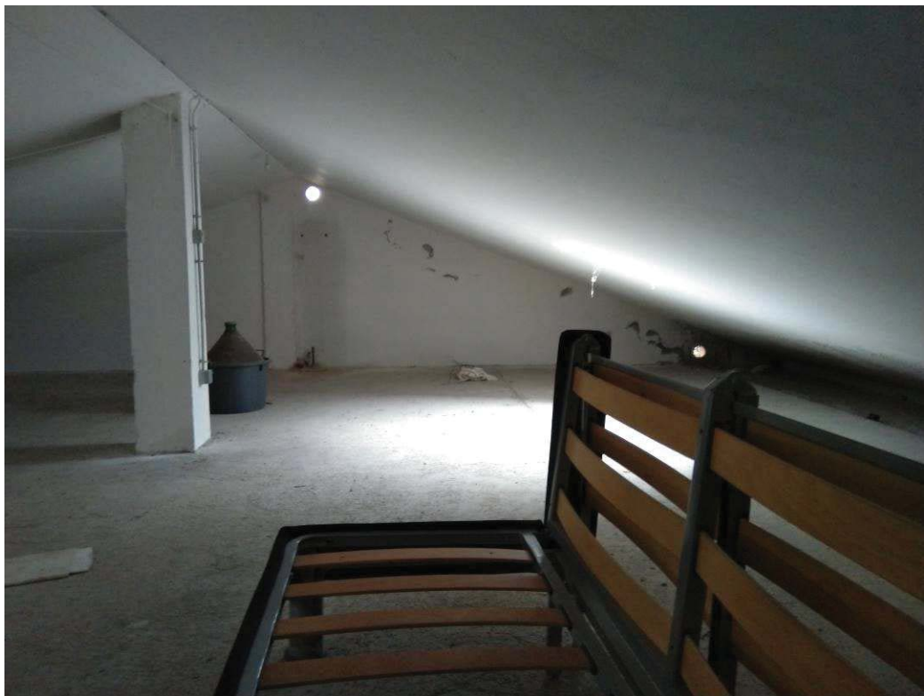
Foto 15. Soffitta – U.I.3 piano secondo
