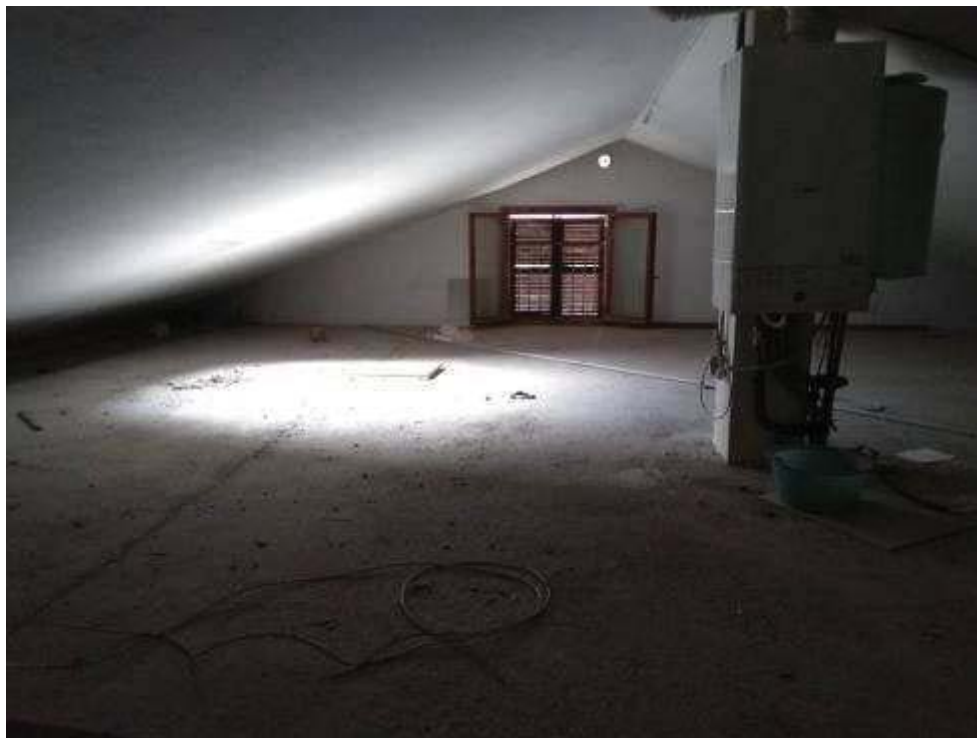
Foto 8. Soffitta – U.I.2 piano secondo
