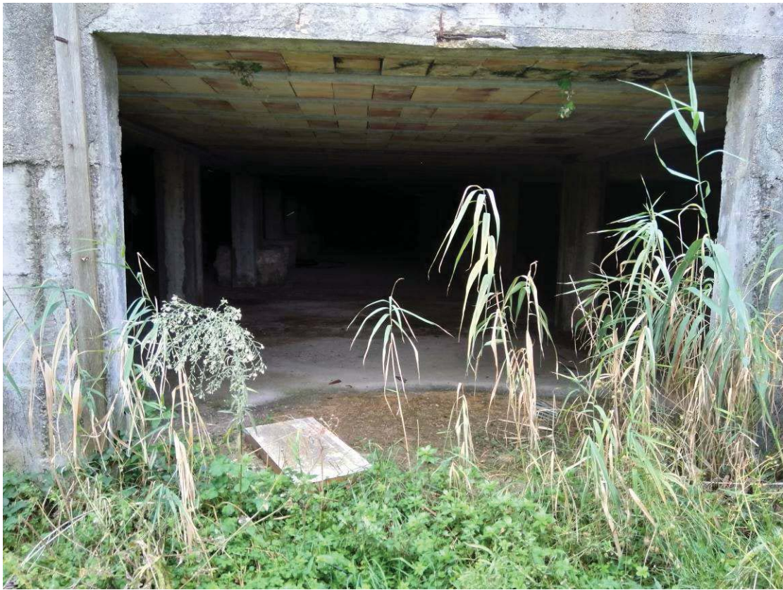
Foto 20. Locale deposito ingresso – piano interrato (SUB.2)
