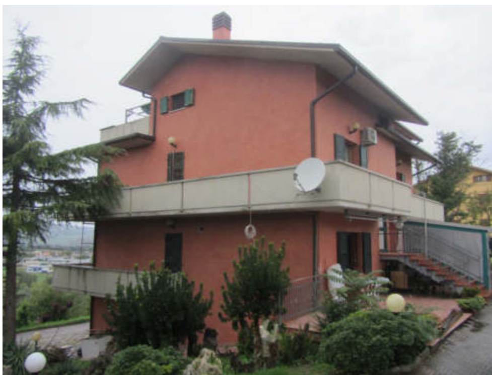
FOTO E.06_ ESTERNO_prospetto laterale
