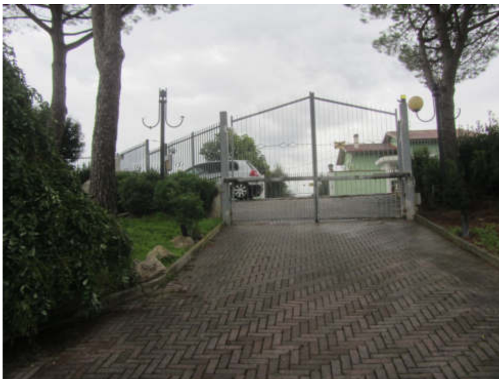
FOTO E.02_ ESTERNO_rampa di accesso
