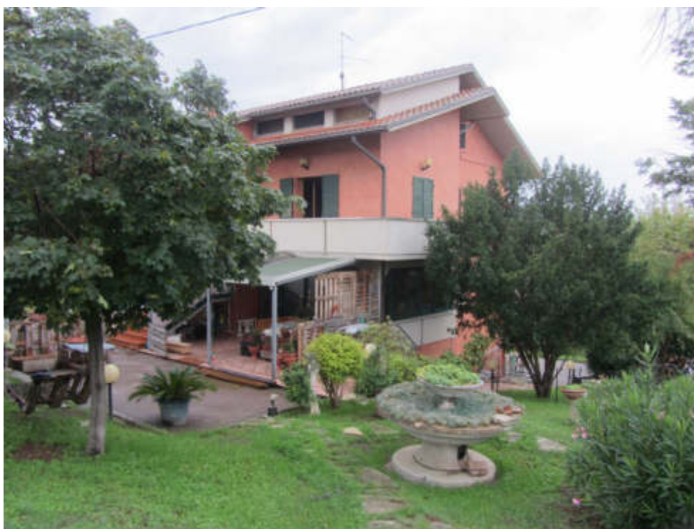
FOTO E.04_ ESTERNO_prospetto laterale
