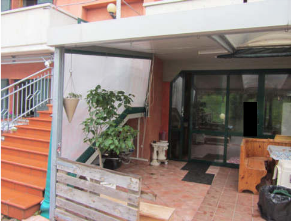
FOTO T.13_ PIANO TERRA_tettoia
