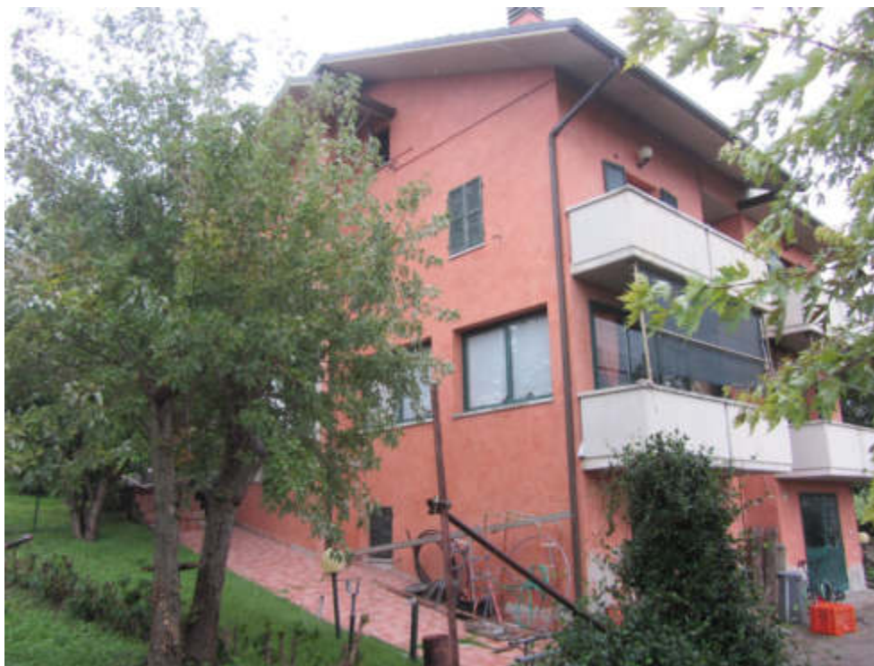
FOTO E.07_ ESTERNO_prospetto laterale
