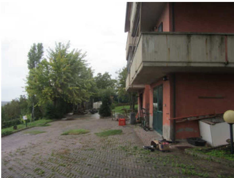
FOTO E.09_ ESTERNO_scoperto retro
