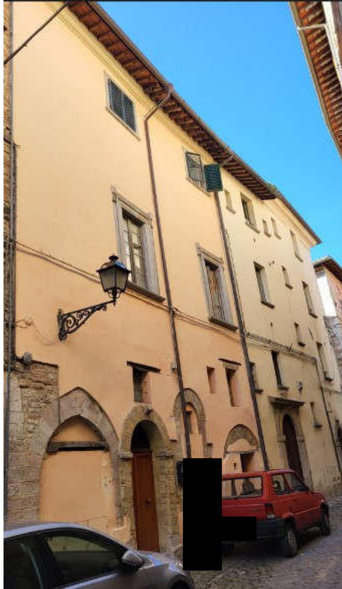
Immagine 1: facciata principale del fabbricato prospiciente la pubblica via
