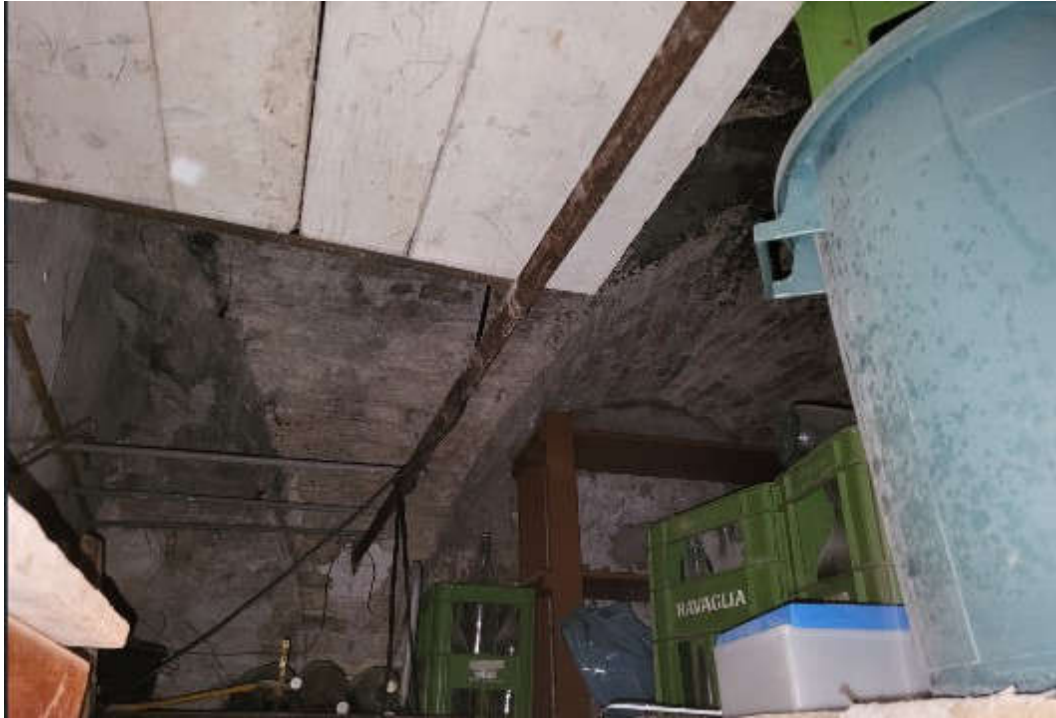
Immagine 6: legnaia, solaio copertura
