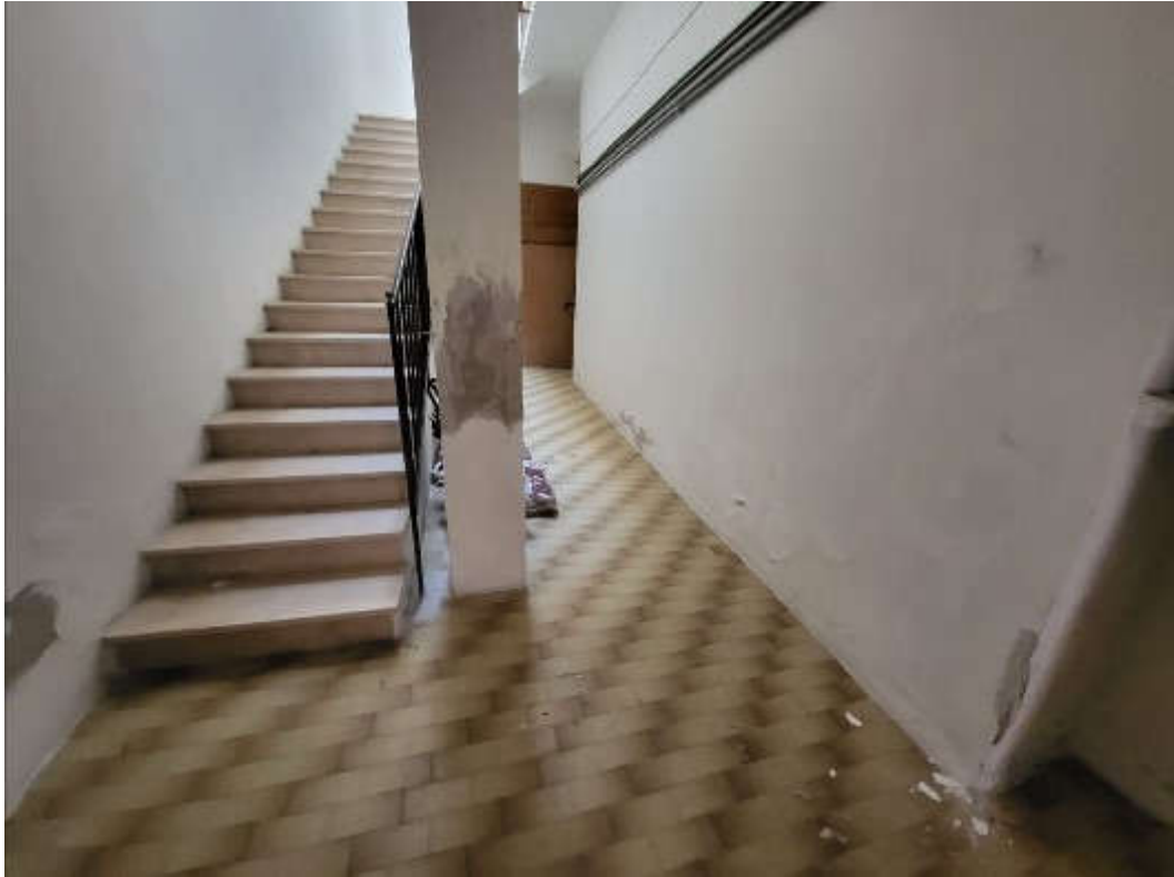
Immagine 2: ingresso al fabbricato e scala interna comune
