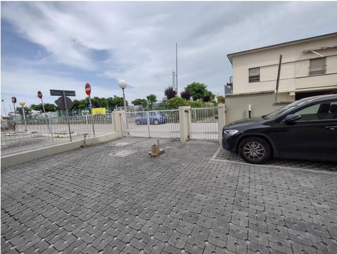
FOTO 18. Accesso carrabile alla corte condominiale e il primo dei posti auto di proprietà
