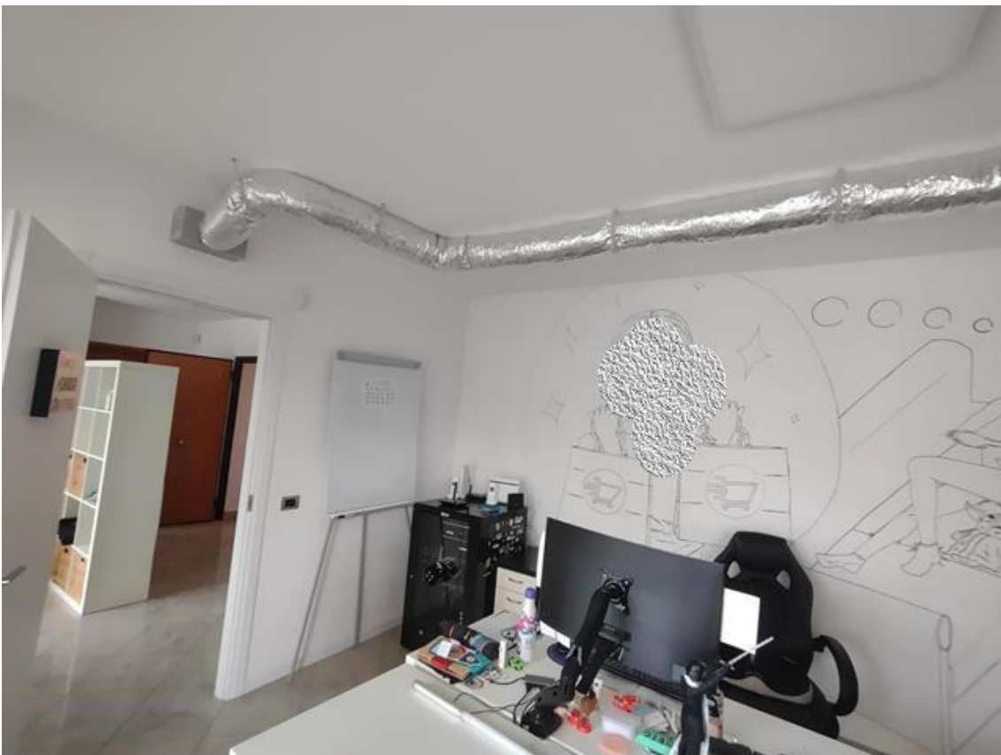
FOTO 10. Ufficio (sub 4): il terzo vano
