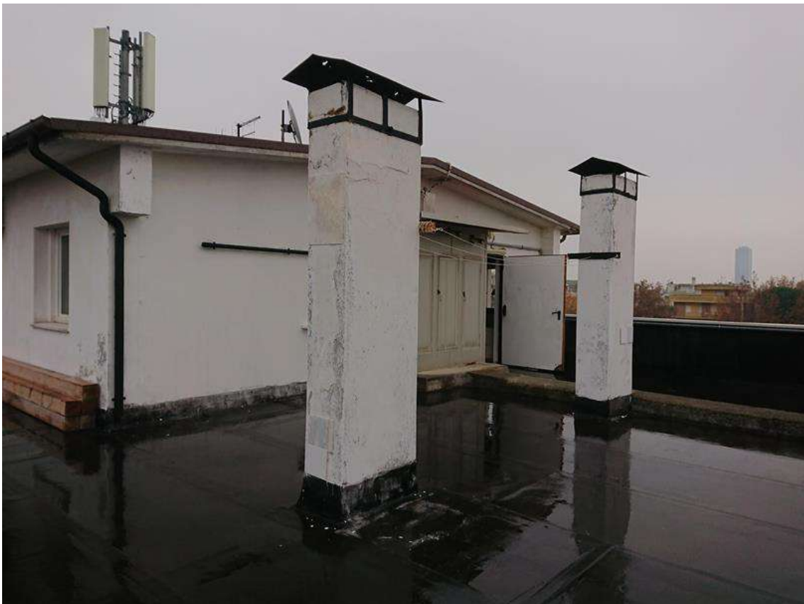
FOTO 56. Piano quinto: il fabbricato e il lastrico di copertura
