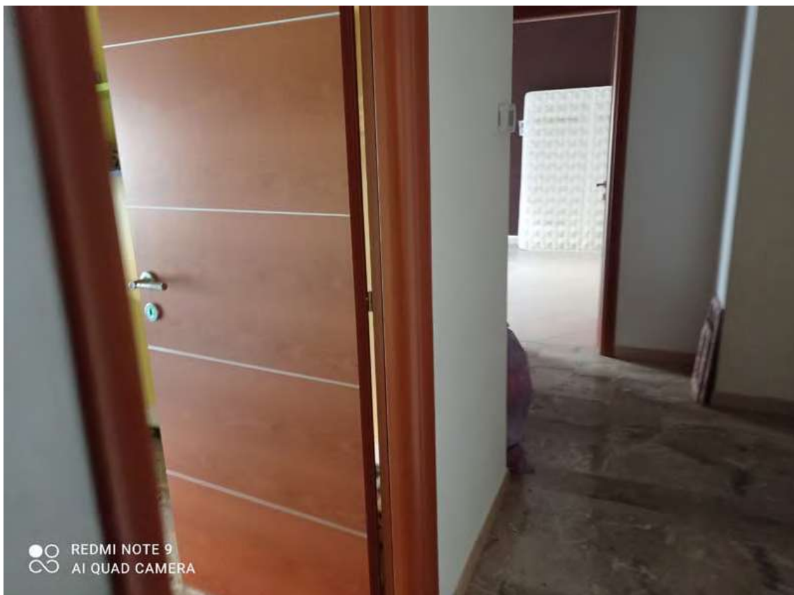
Foto 5 – LOTTO A – disimpegno
