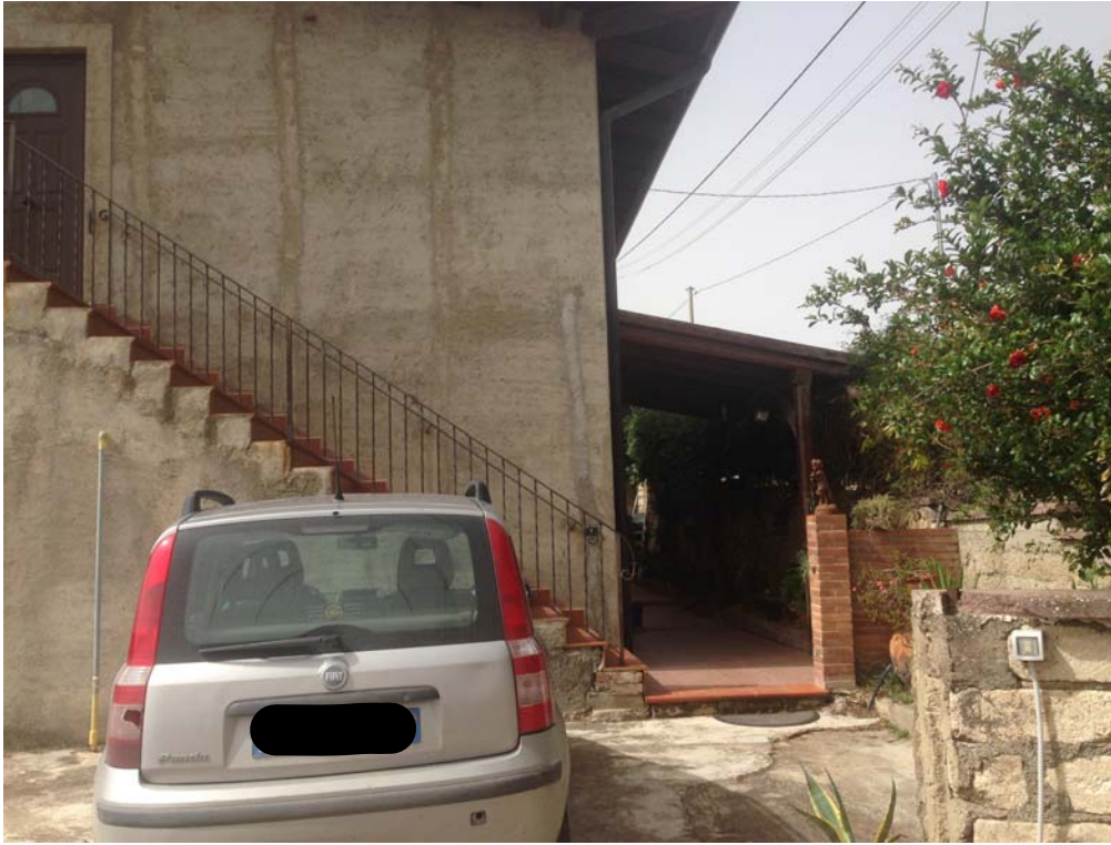
Figure 3- Scala esterna per accesso al piano primo e Tettoia in legno
