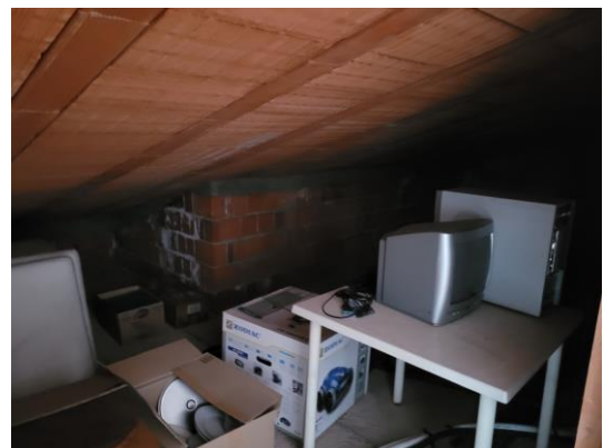
SOTTETTO (PARTE GREZZA)
