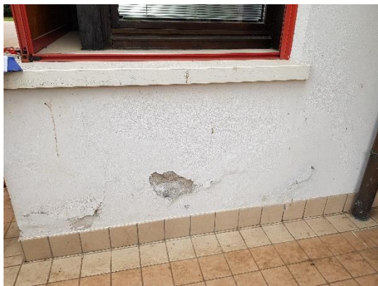
INFILTRAZIONI/UMIDITA'
