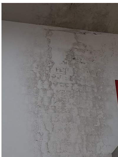
INFILTRAZIONE UFFICIO
