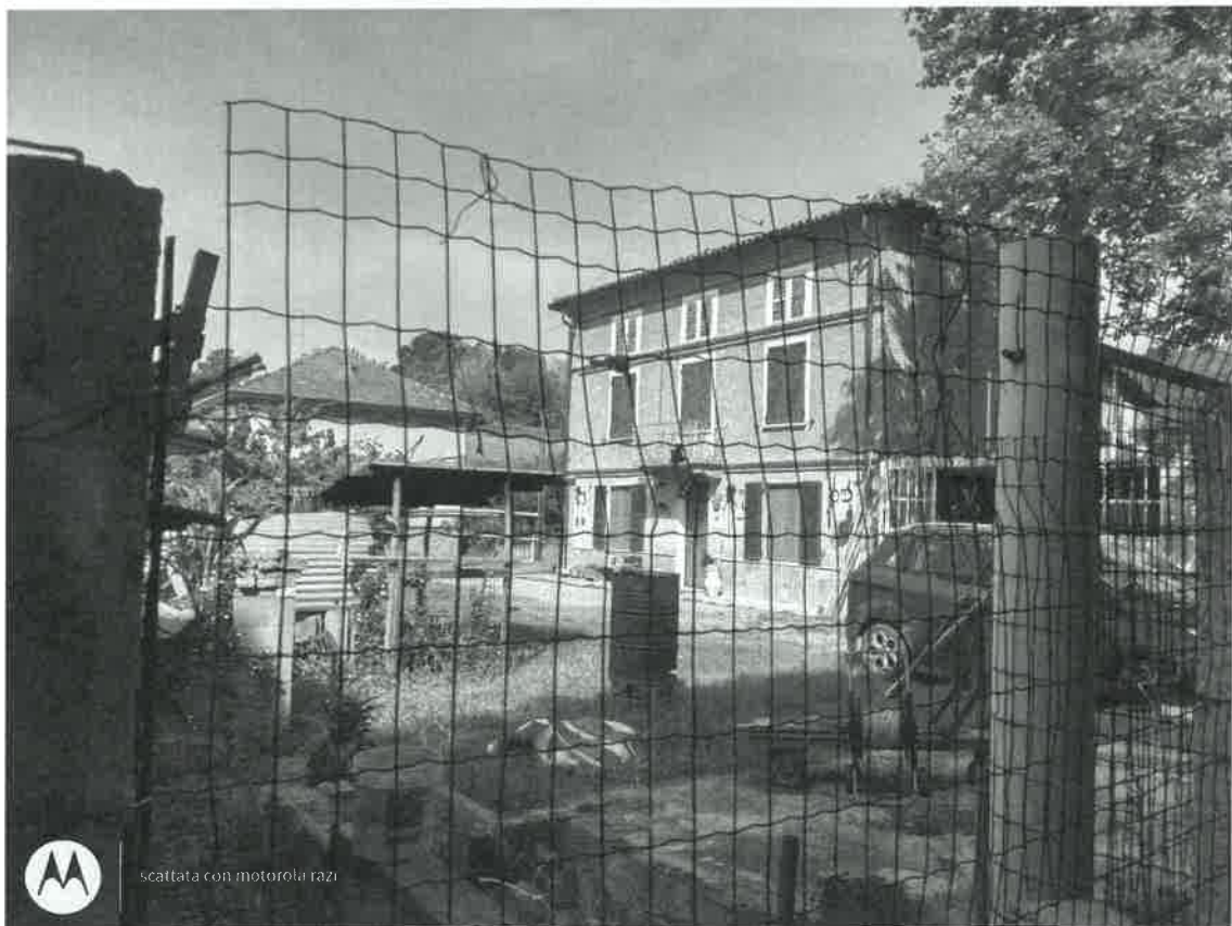
Vista esterna del compendio
