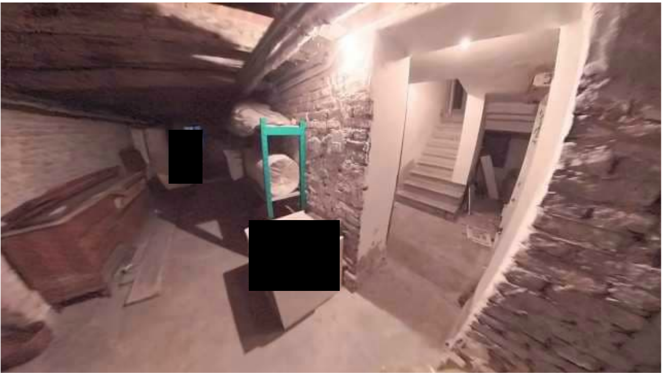
Figura 61 CANTINE AL PIANO SEMINTERRATO
