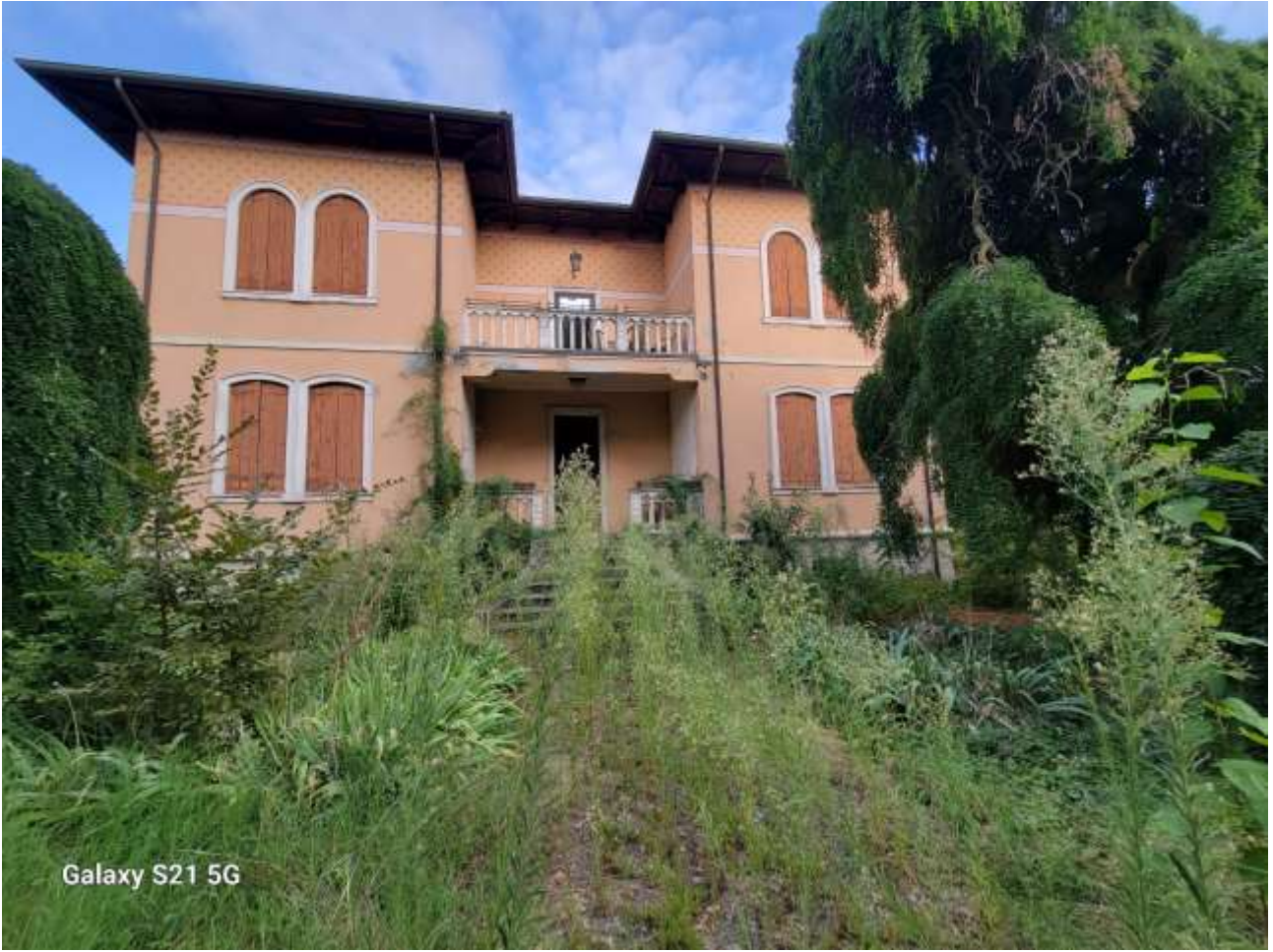
Figura 6 FACCIATA PRINCIPALE DELLA VILLA
