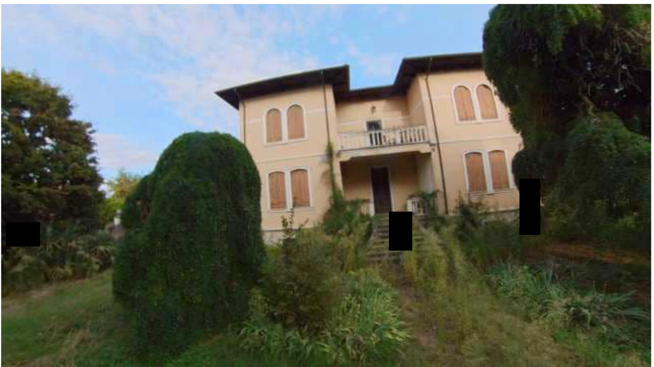
Figura 5 FACCIATA PRINCIPALE DELLA VILLA
