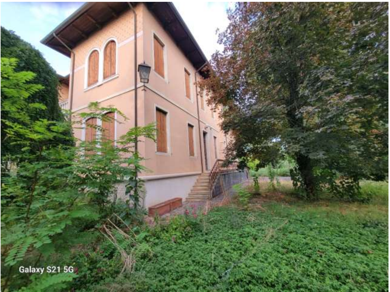
Figura 9 VEDUTA ESTERNA SUD-OVEST
