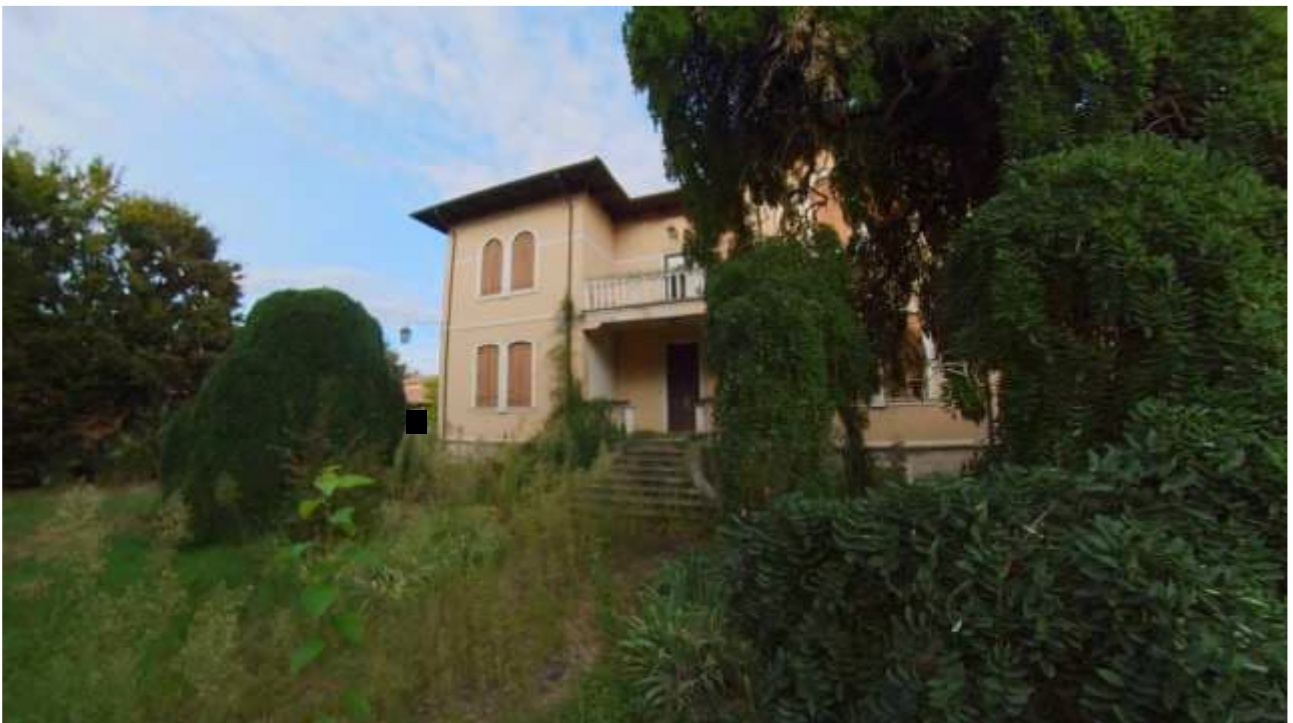
Figura 7 FACCIATA PRINCIPALE DELLA VILLA
