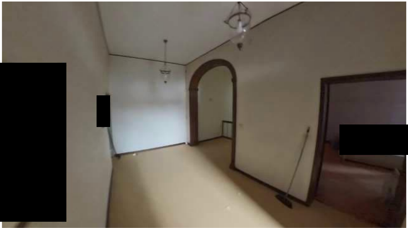
Figura 39 INTERNI PRIMO PIANO
