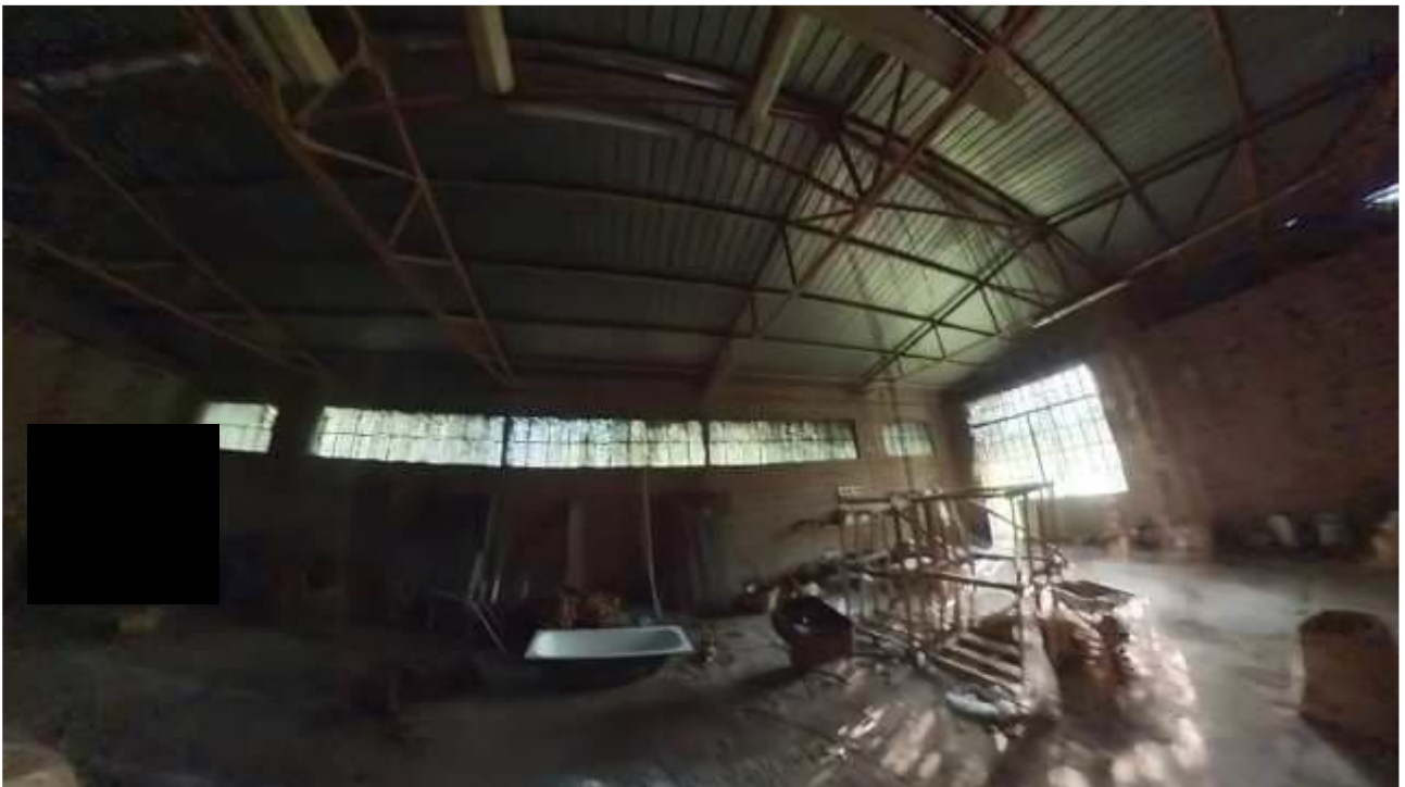
Figura 71MAGAZZINO IN PERTINENZA A NORD DELLA VILLA
