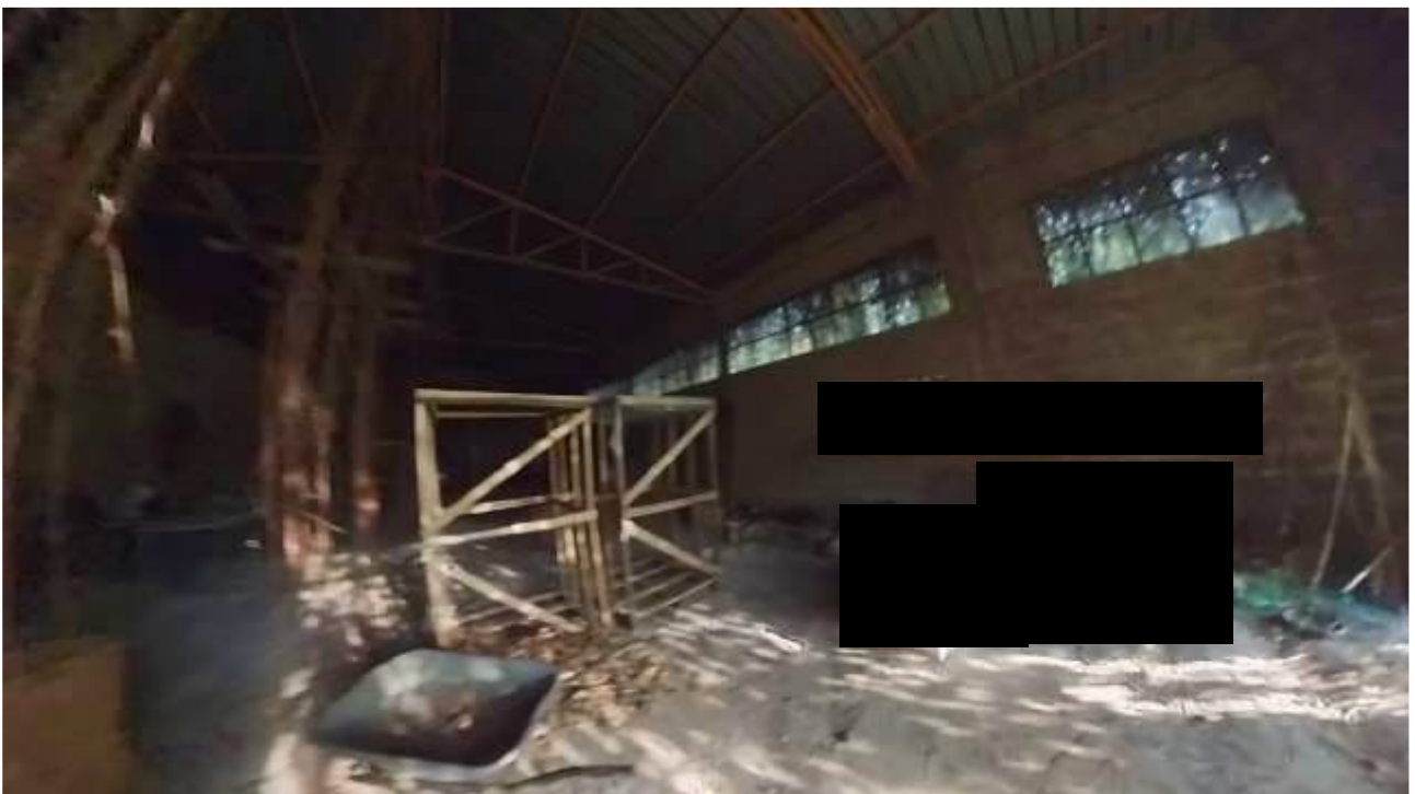
Figura 69MAGAZZINO IN PERTINENZA A NORD DELLA VILLA
