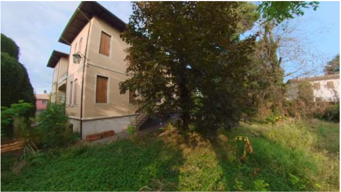
Figura 8 VEDUTA LATERALE SUD
