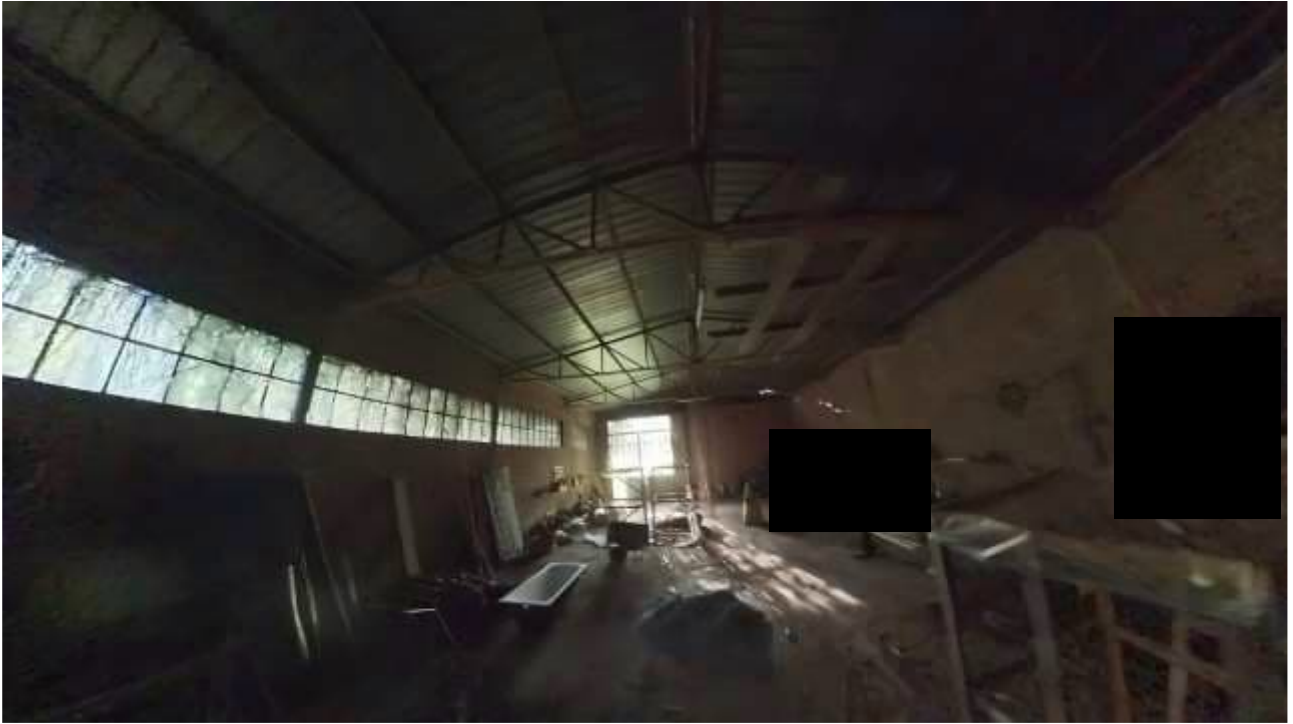
Figura 70MAGAZZINO IN PERTINENZA A NORD DELLA VILLA
