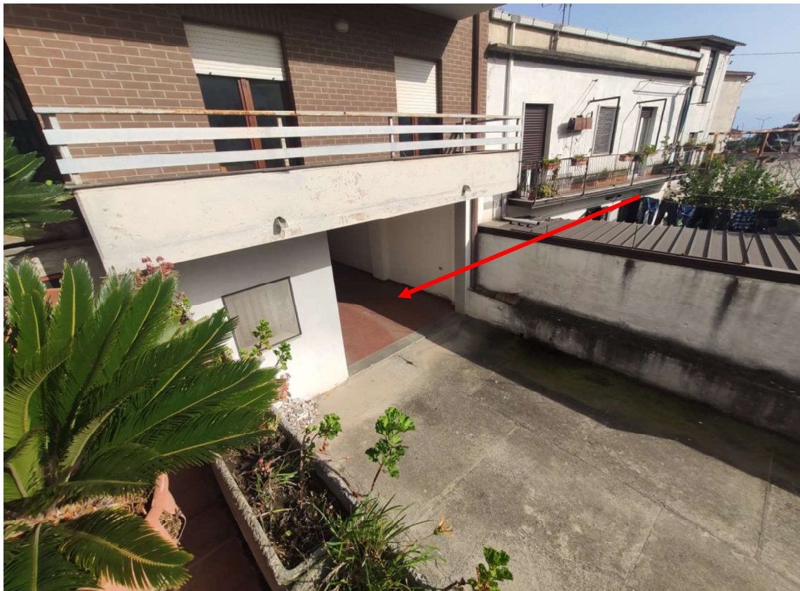
6. Veduta verso l'ingresso carrabile al piano sottostrada, magazzini, per l'accesso al Lotto 2
