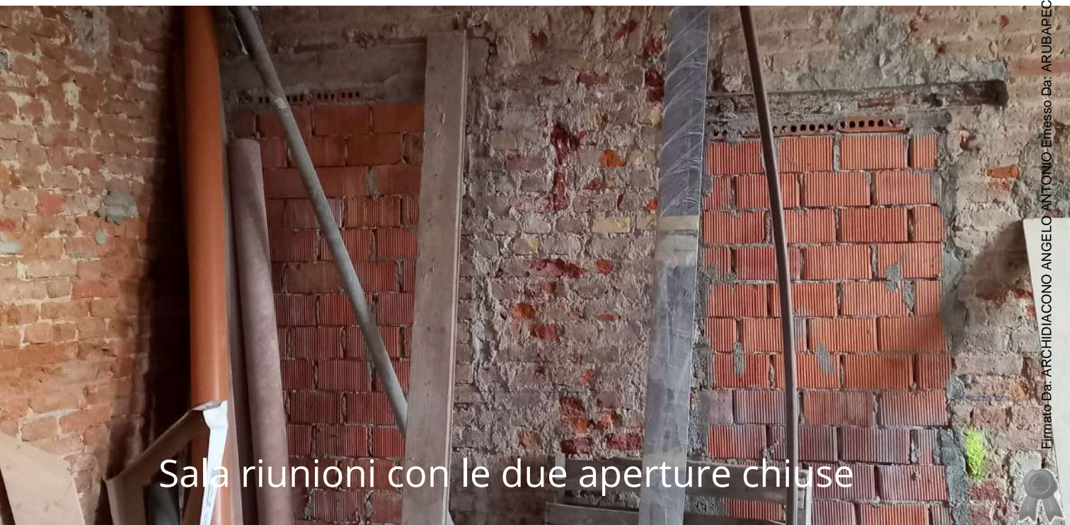
Finestre della sala su pareti in mattoni
