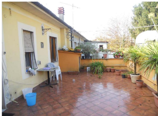
Foto n°10 - Terrazzo dell'immobile al quale si accede dalla portafinestra dell'angolo cottura
