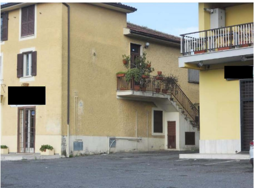
Foto n°4 - Fronte sud est del fabbricato in cui si trova il bene immobile oggetto di esec.ne imm.re
