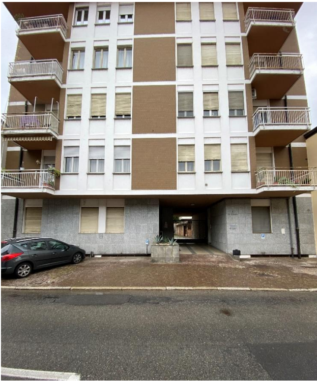
01 – Esterno facciata verso ingresso su via Volta 40
