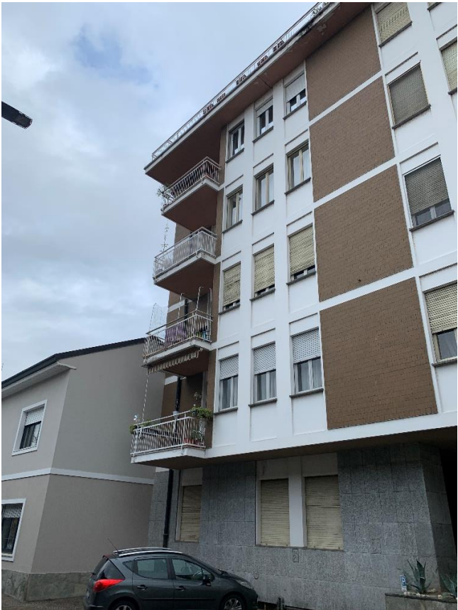
02 – Esterno facciata verso ingresso su via Volta 40
