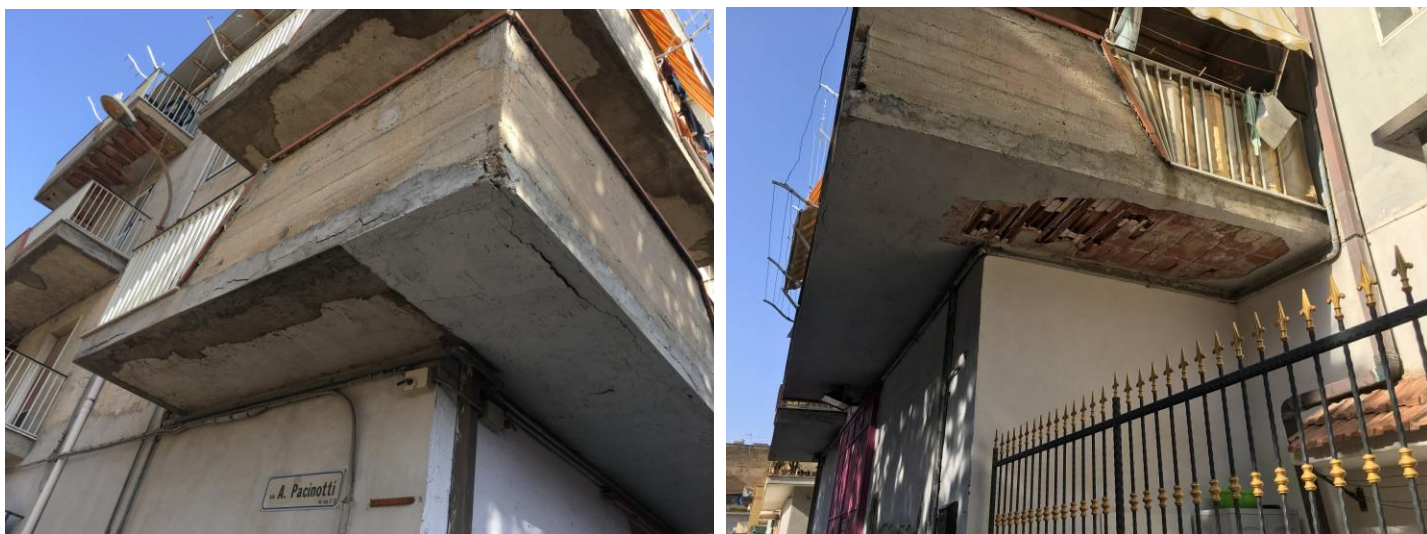
Foto 5 e 6 –Particolare intradosso balconi a primo piano
