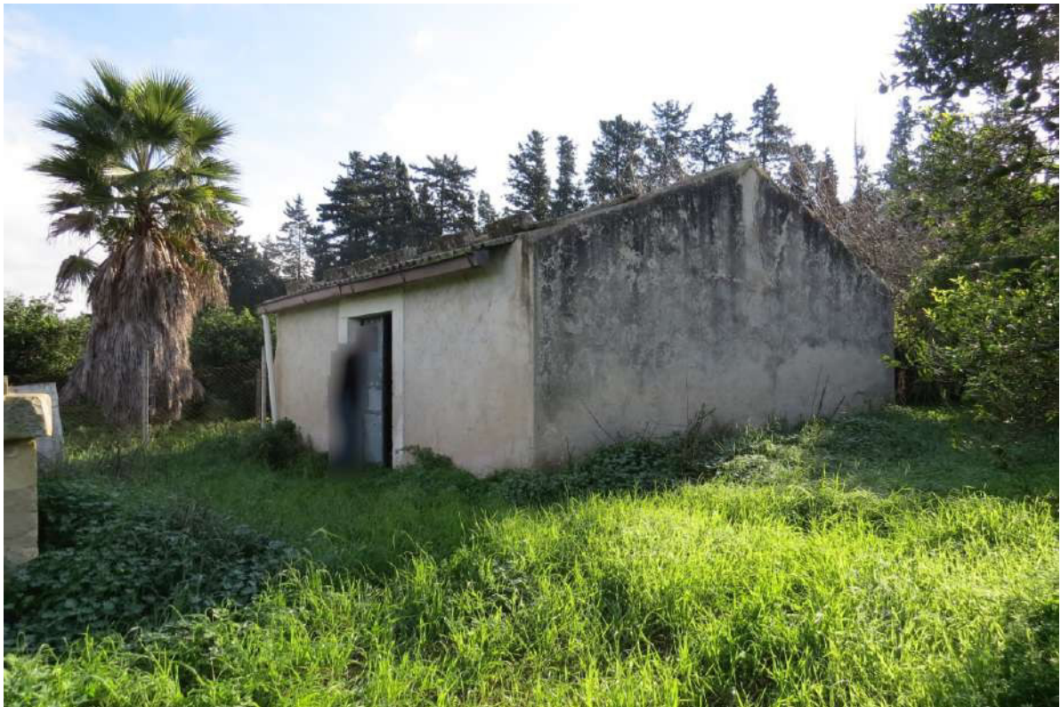
Foto n. 99 – Lotto 13, Fabbricato rurale.
