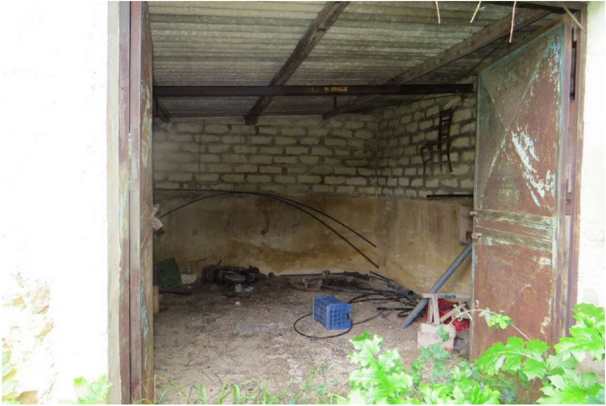
Foto n. 111 – Lotto 15, Fabbricato rurale.
