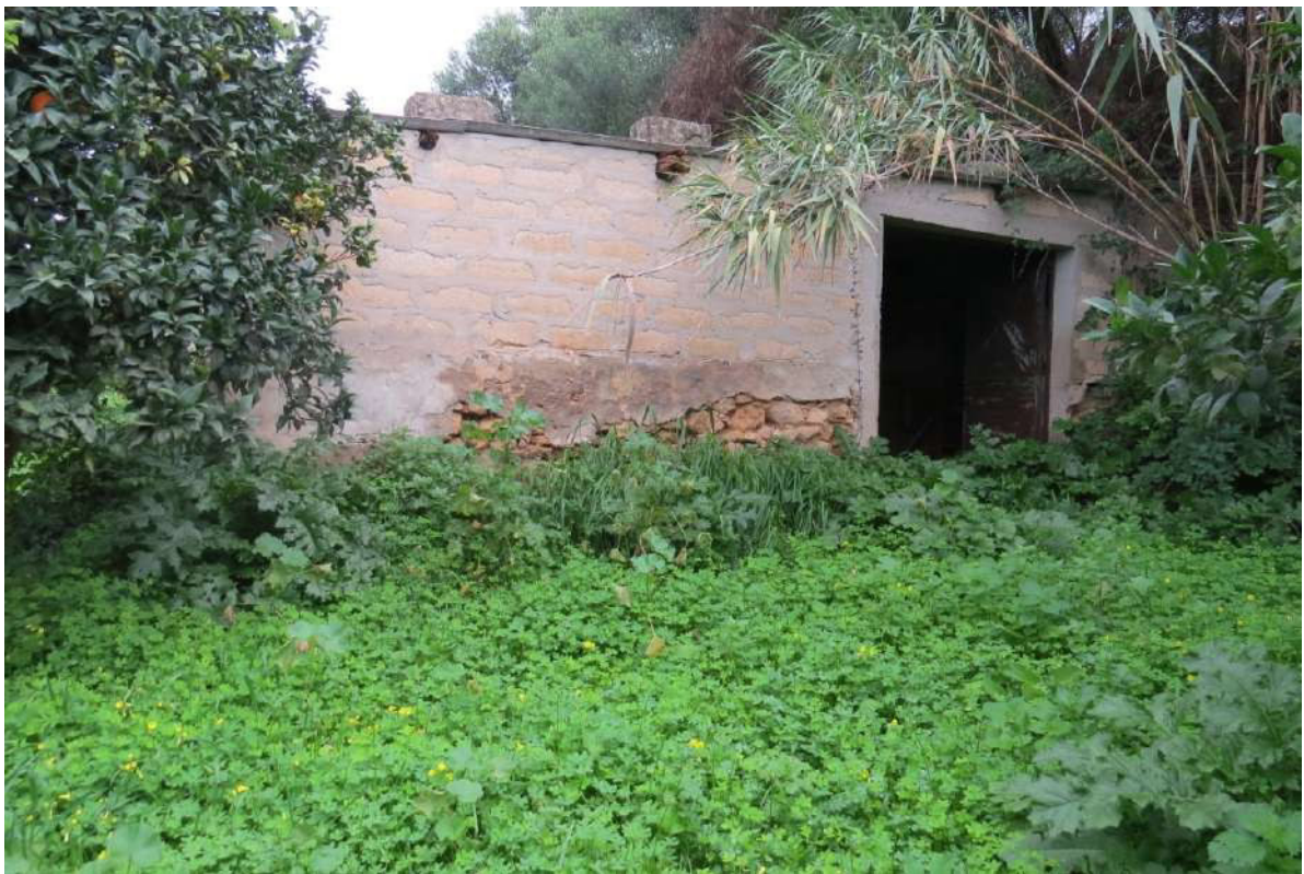
Foto n. 110 – Lotto 15, Fabbricato rurale.
