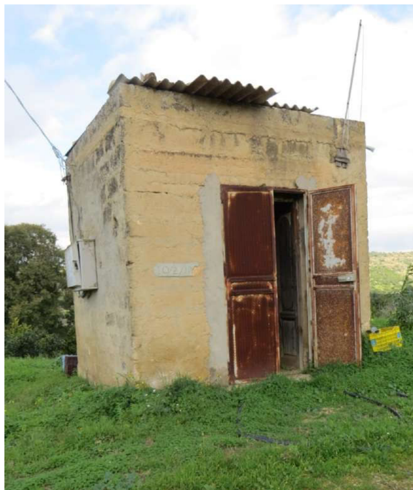
Foto n. 108 – Lotto 15, Fabbricato rurale.
