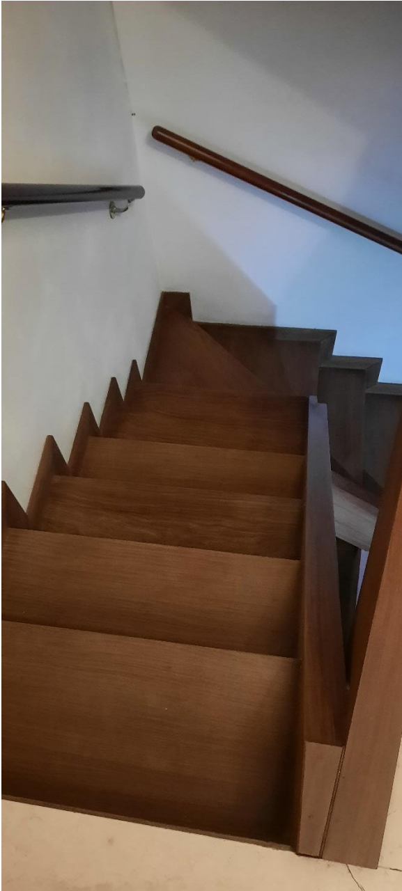
Foto 32 – Particolare sbarco scala da Piano Primo a Piano Mansarda
