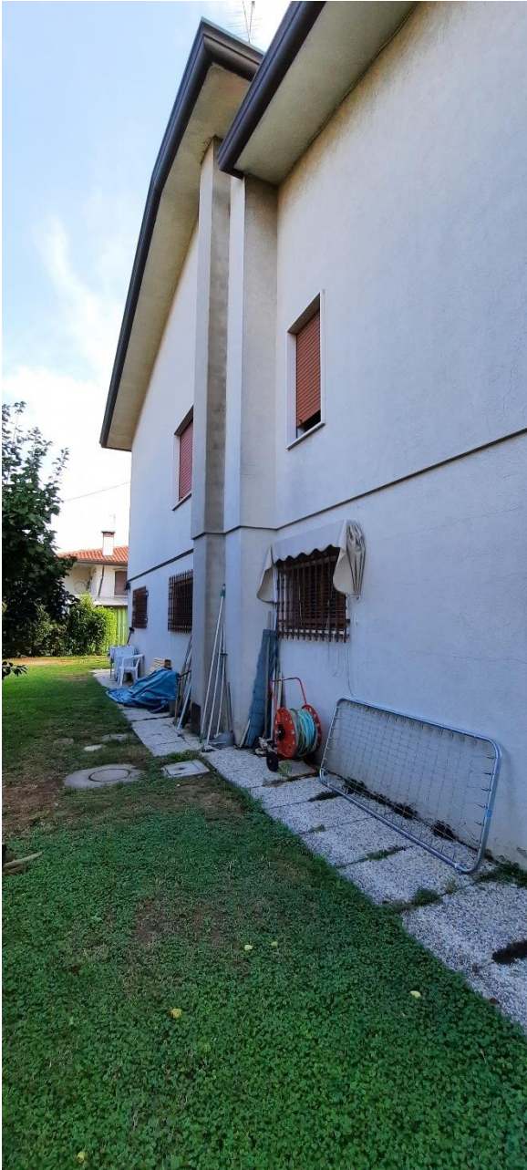
Foto 5 – Edificio Residenziale Vista Prospetto Ovest
