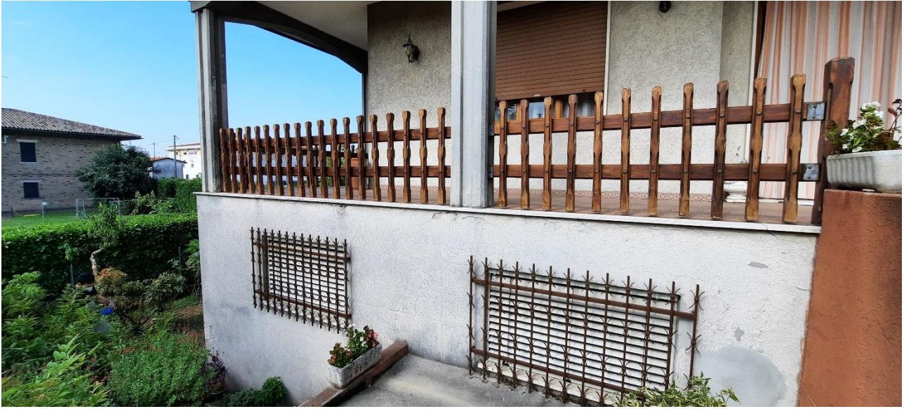
Foto 7-8-9 – Edificio Residenziale - Particolari Prospetto Est
