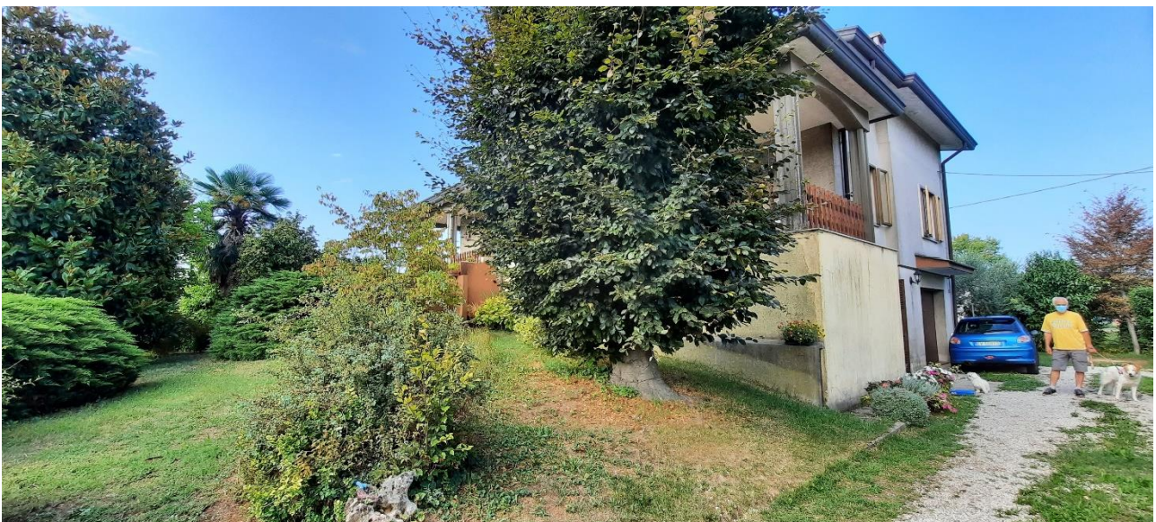
Foto 2 – Edificio Residenziale - Vista Prospetto Est e Nord
