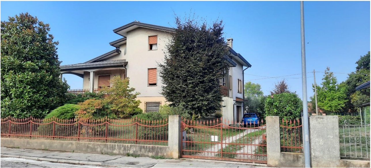
Foto 1 – Edificio Residenziale - Prospetto principale Est
