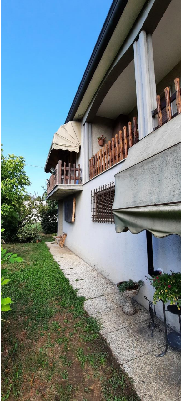
Foto 6 – Edificio Residenziale Vista Prospetto Sud
