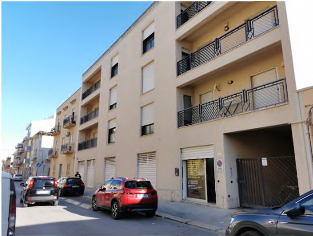
INGRESSO VIA DEL LEGNO
