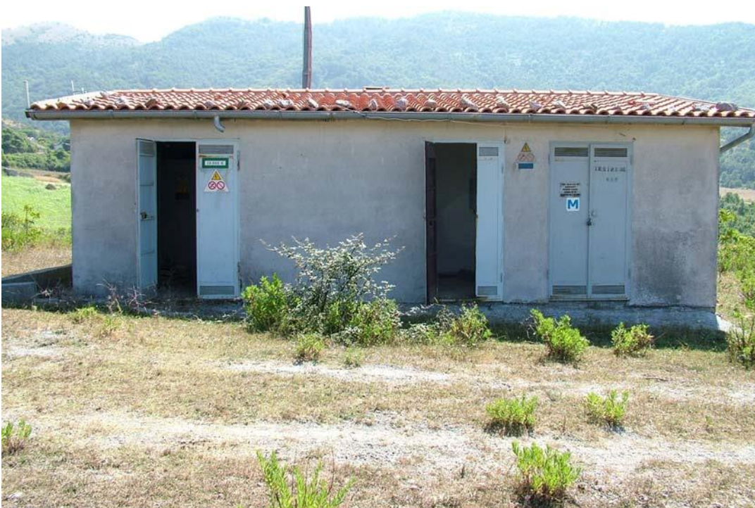
Foto 8 - Immobile (cabina a monte) foglio 3, particella 208, Sub. 1 (lato ovest)
