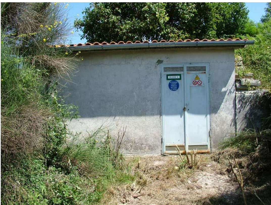
Foto 11 - Immobile (cabina a valle) foglio 3, particella 210, Sub. 1 (lato sud)
