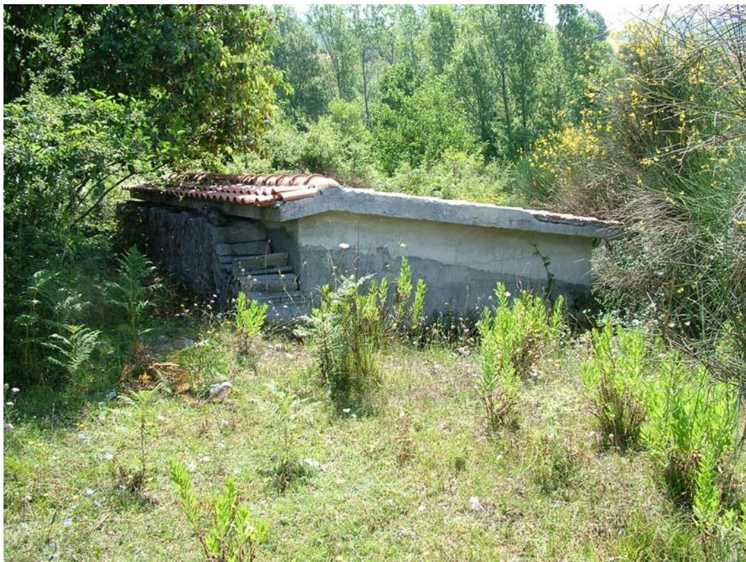
Foto 12 - Immobile (cabina a valle) foglio 3, particella 210, Sub. 1 (lato nord-ovest)
