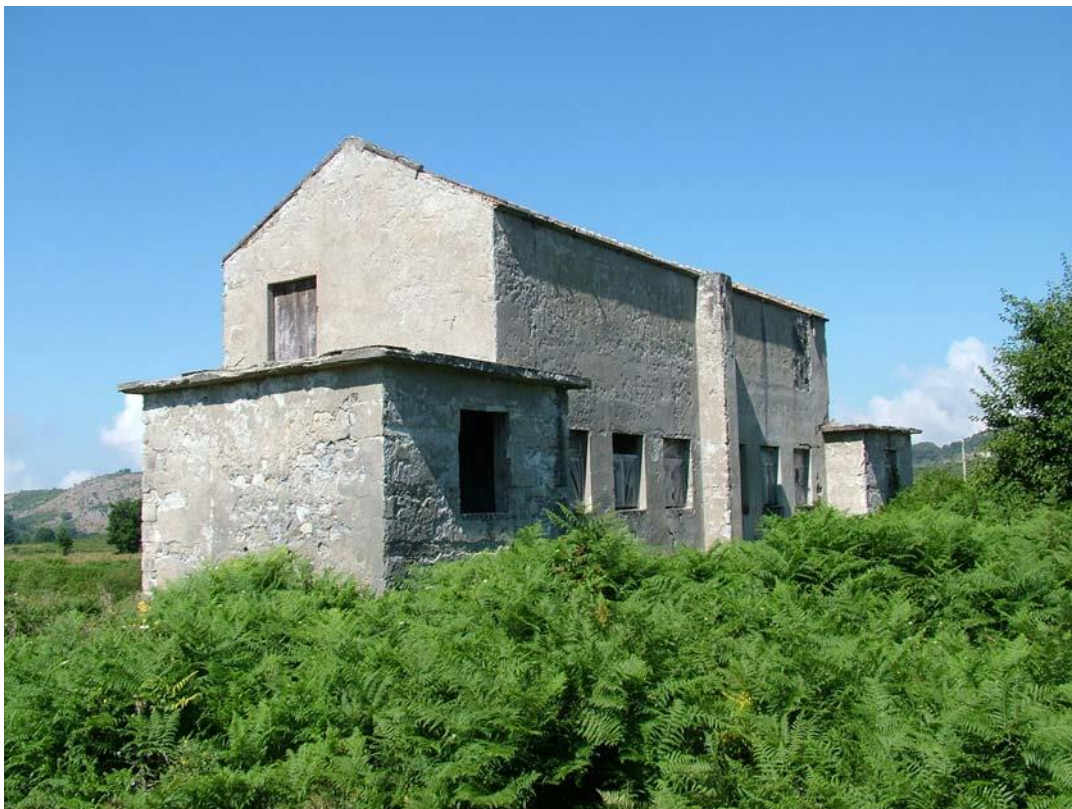
Foto 7 - Immobile foglio 3, particella 189, Sub. 1 (lato est)
