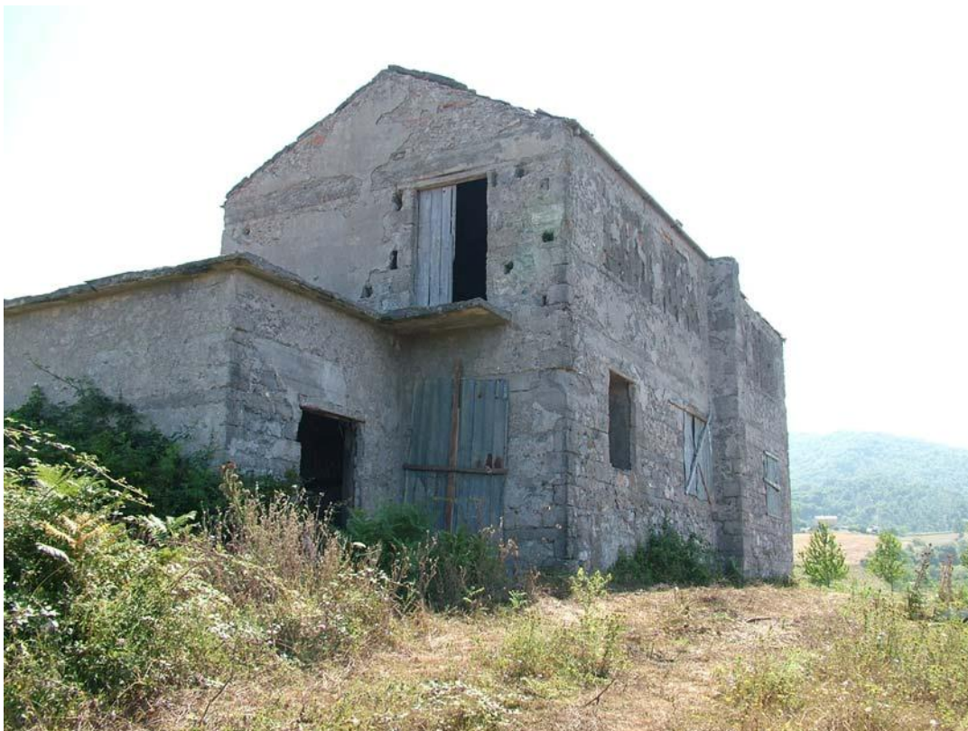
Foto 5 - Immobile foglio 3, particella 189, Sub. 1 (lato sud-ovest)
