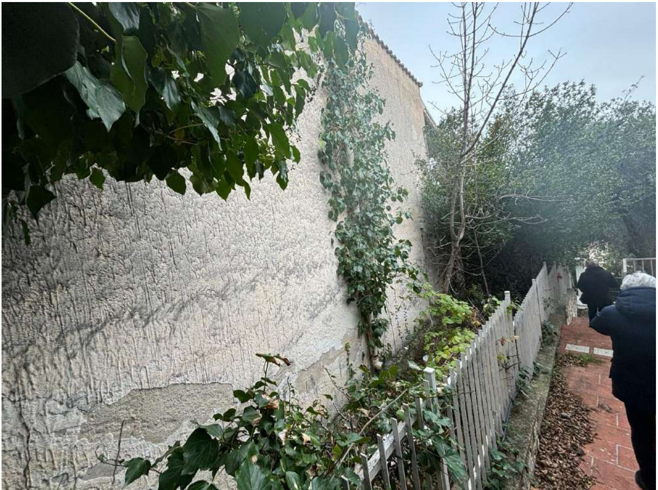
Foto n. 18 – Particolare del prospetto laterale (ovest) dell'immobile
