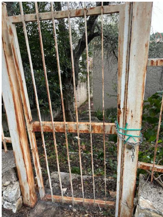
Foto n. 3 – Ingresso posteriore all'immobile
