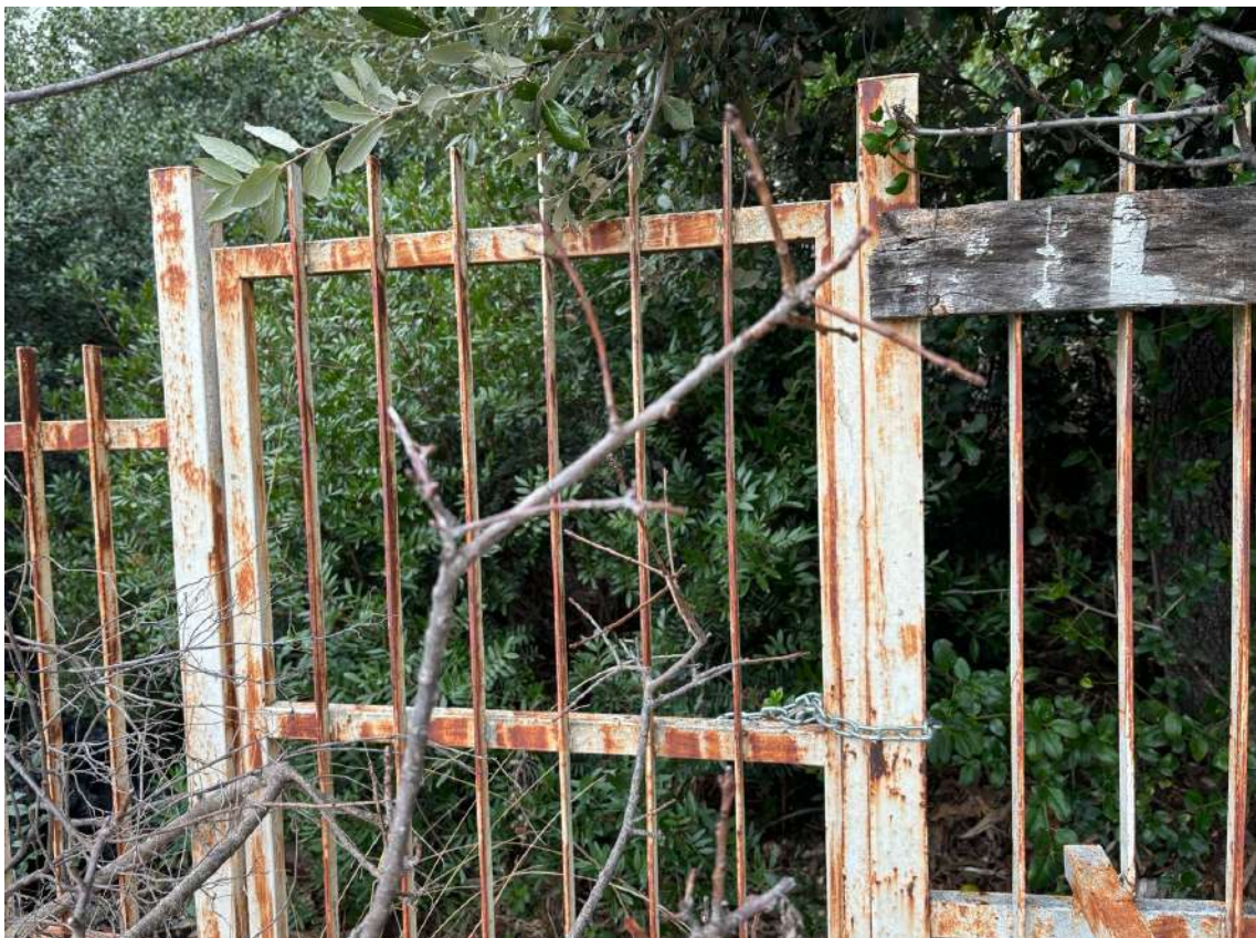
Foto n. 12 – Ingresso principale dell'immobile
