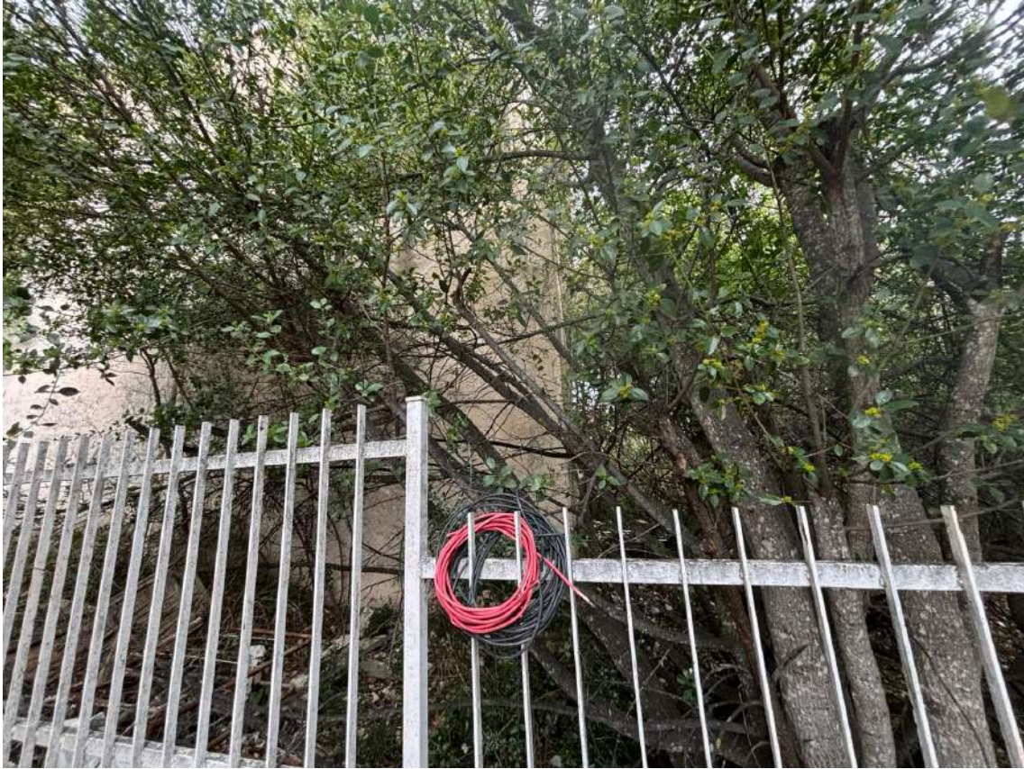
Foto n. 13 – Prospetto laterale (ovest) dell'immobile
