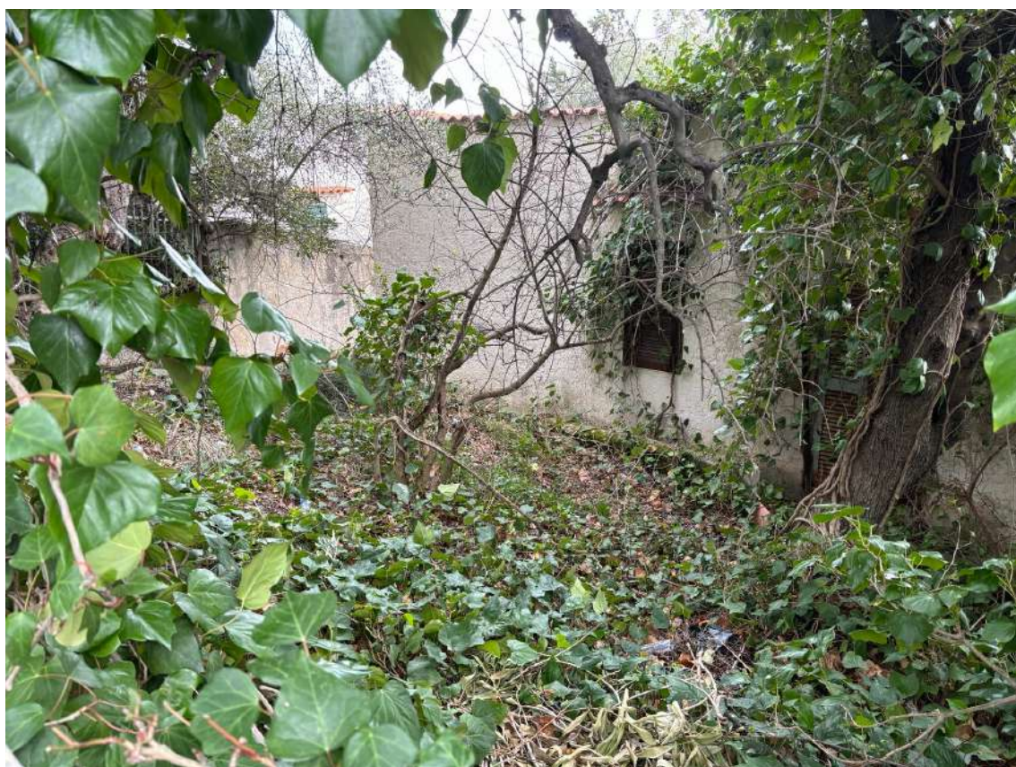
Foto n. 6 – Prospetto posteriore dell'immobile e area pertinenziale
