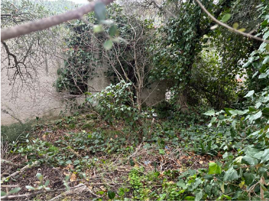
Foto n. 9 – Prospetto posteriore dell'immobile
