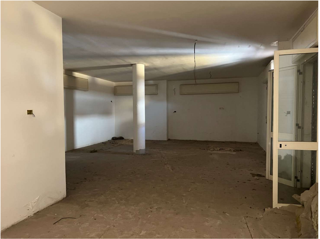
Foto 5 – Vista dell'interno del locale, attualmente fuso con quello limitrofo
