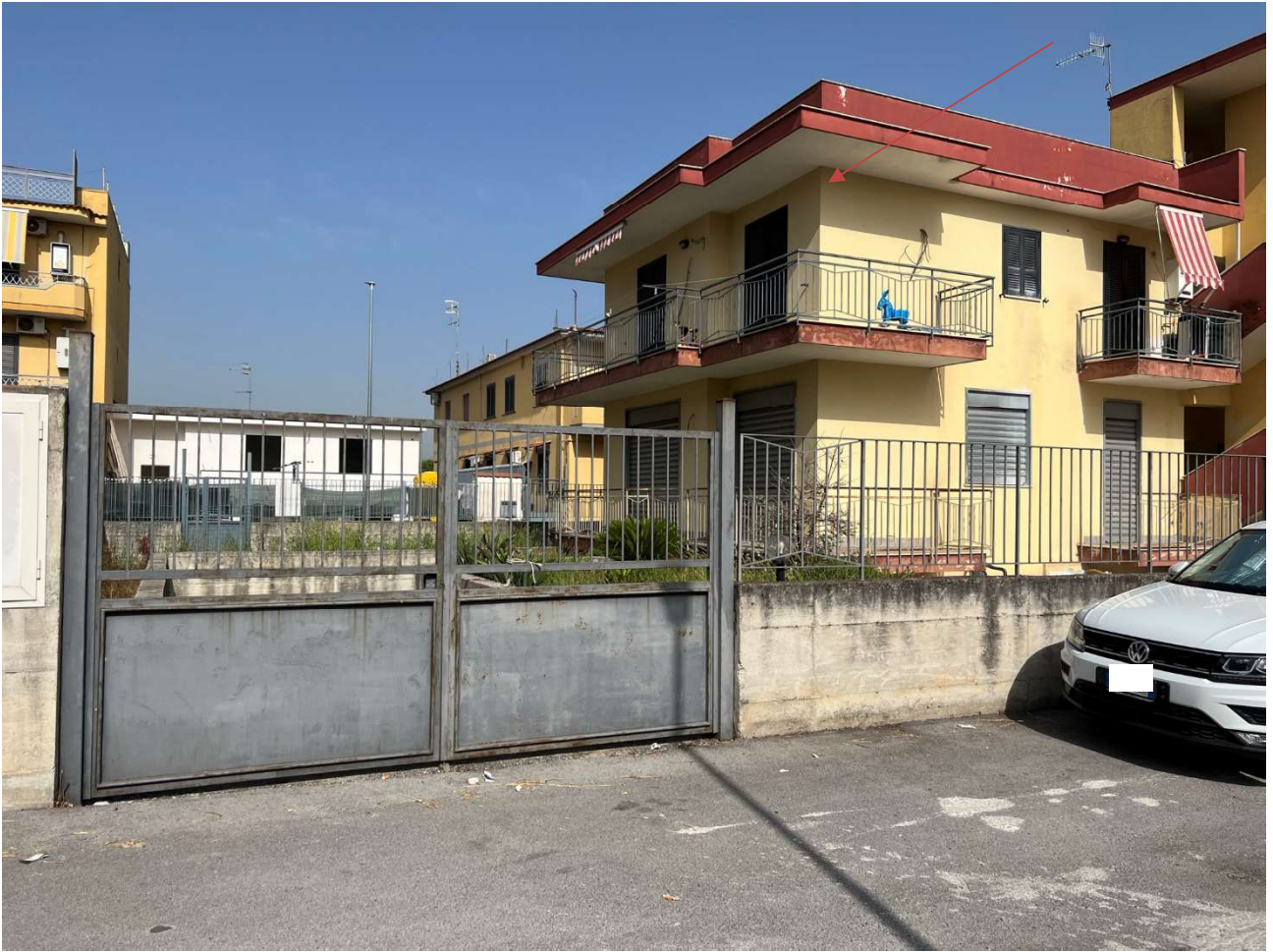
Foto 3 – Vista dell'ingresso carrabile del fabbricato
