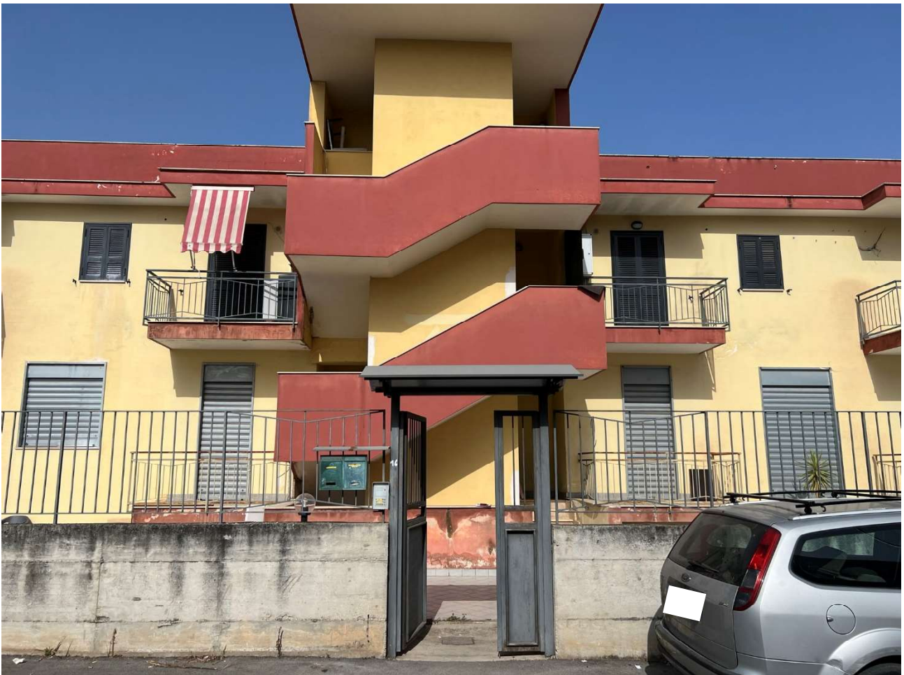
Foto 2 – Vista dell'ingresso pedonale del fabbricato posto al civico n. 16 di Traversa Berlinguer – Castello di Cisterna (Na)
