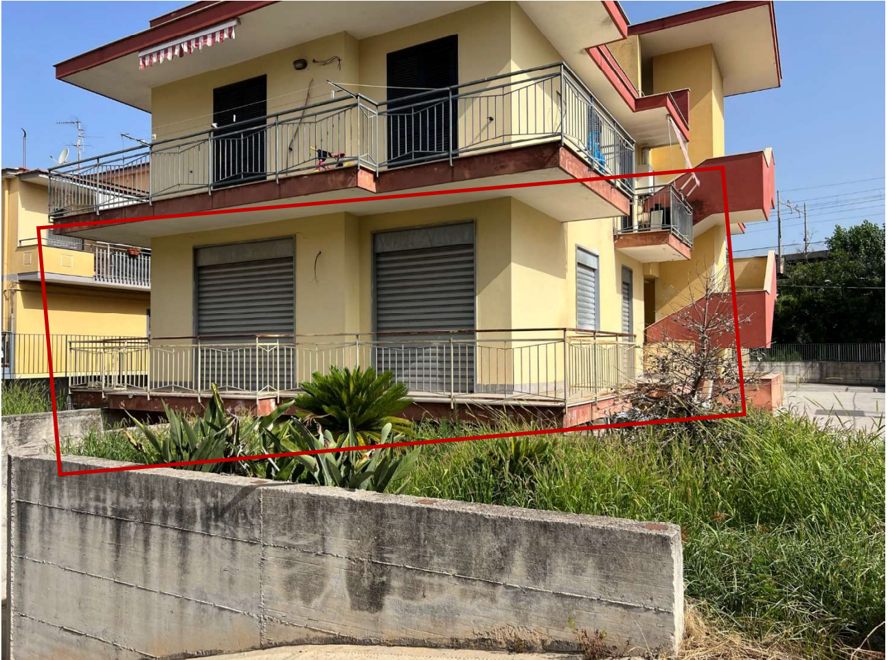
Foto 10 – Vista esterna del locale staggito e della relativa area esterna pertinenziale
