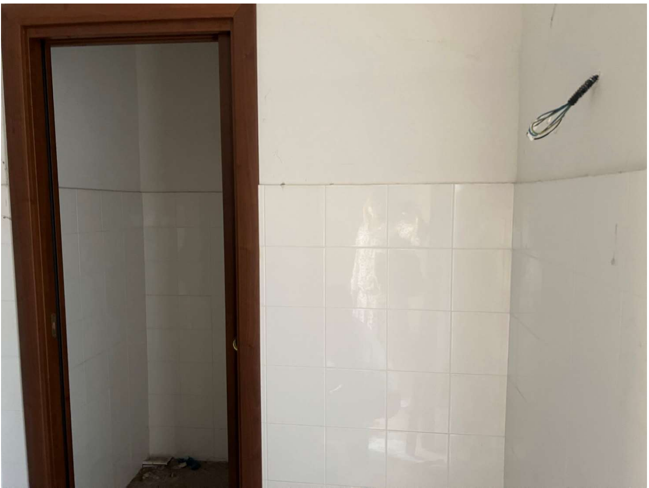
Foto 9 – Vista dell'area di servizio, non ultimata
