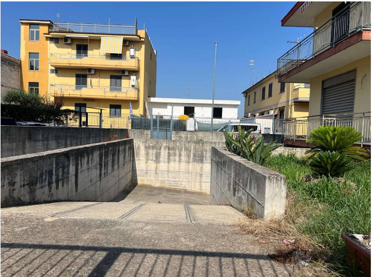
Foto 14 – Vista della rampa che porta al piano seminterrato e che attraversa l'area esterna pertinenziale
