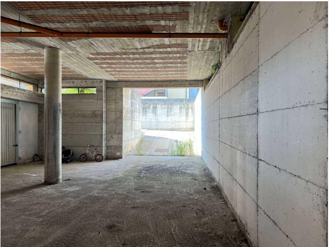
Foto 15 – Vista del piano seminterrato
