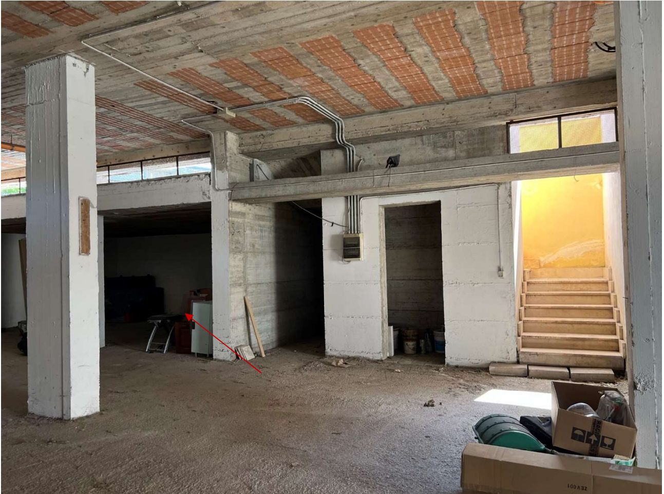
Foto 16 – Vista del piano seminterrato con evidenza dell'area corrispondente al box pignorato
