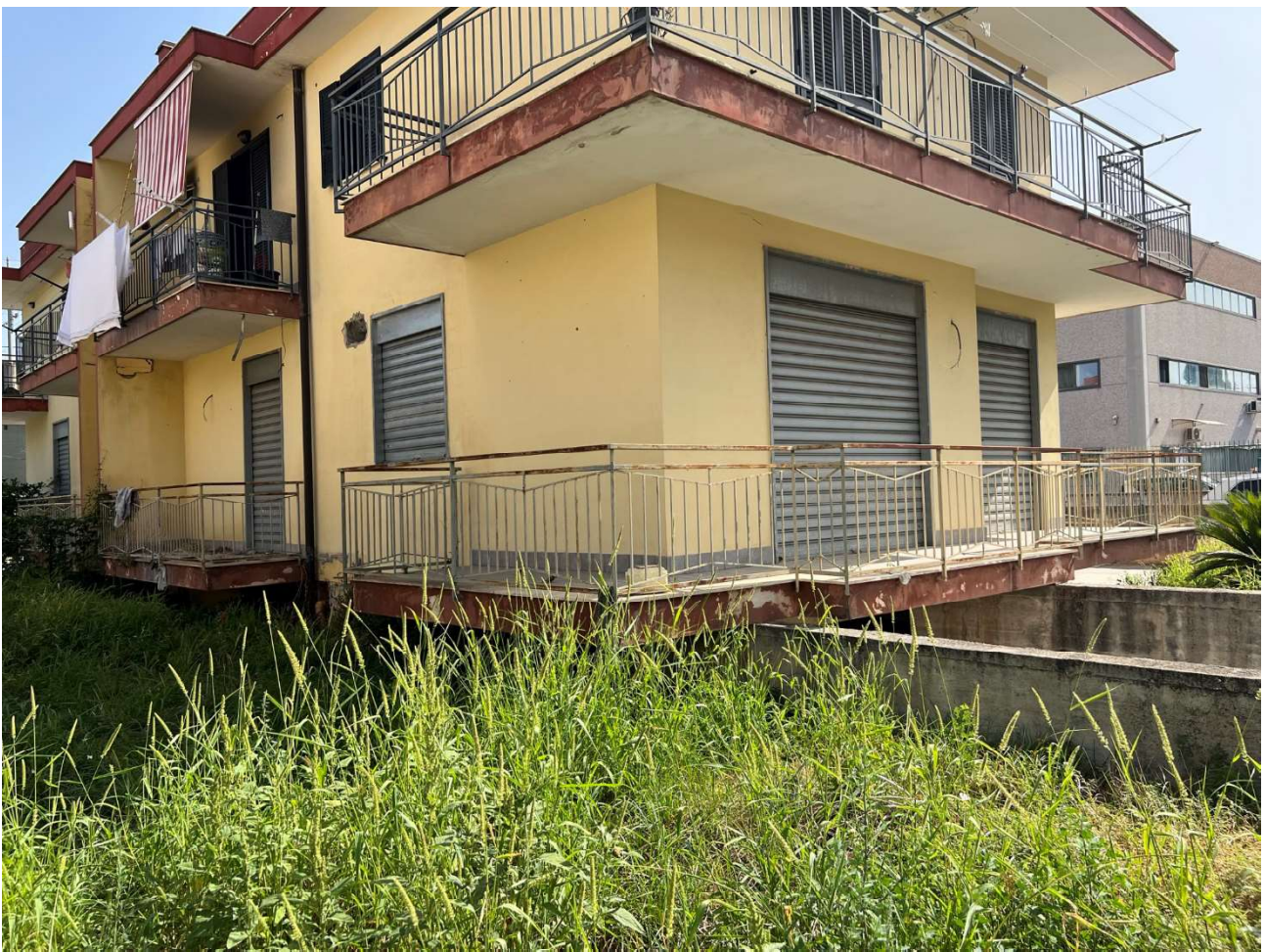
Foto 13 – Vista esterna del locale staggito e della relativa area esterna pertinenziale
