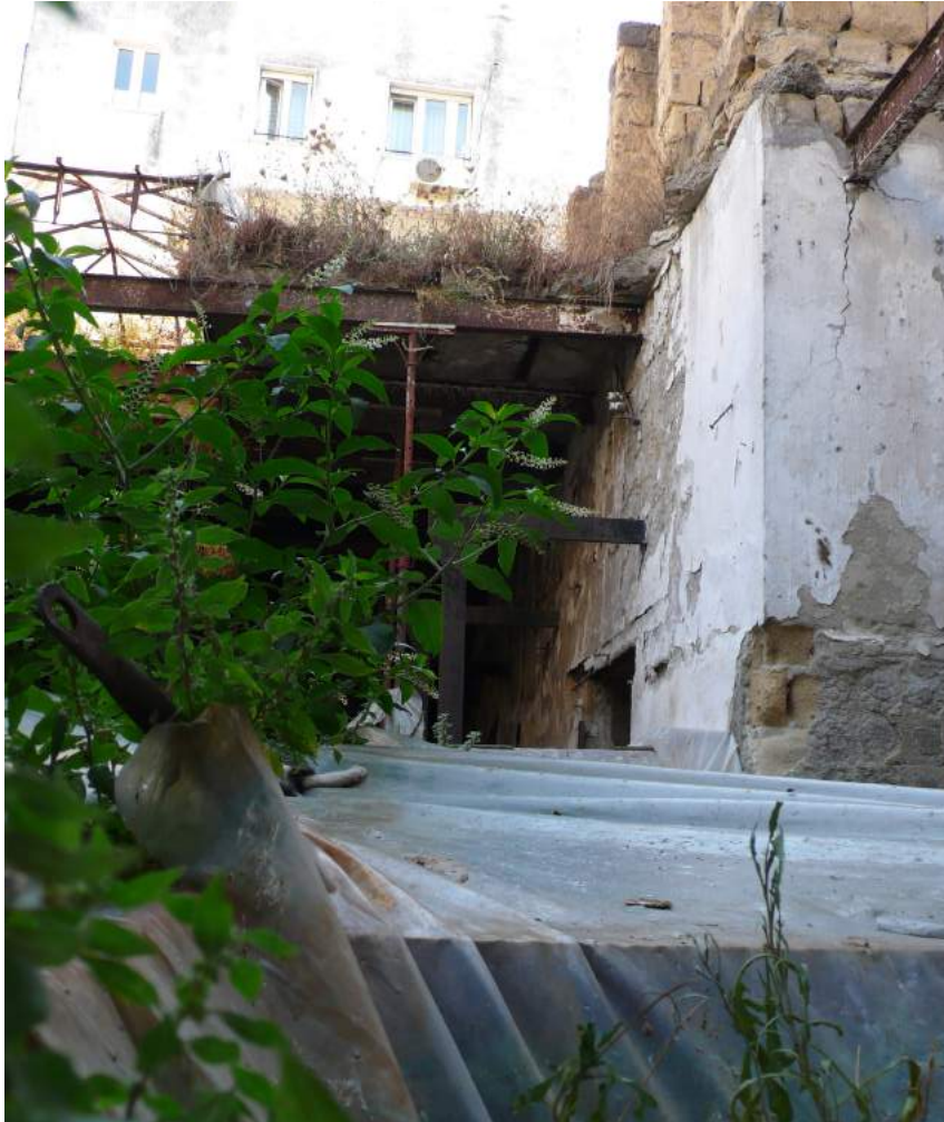
Immagine D : particolare spazio interno edificio in Napoli in via Santa Maria delle Grazie a Loreto n 17,18,19
