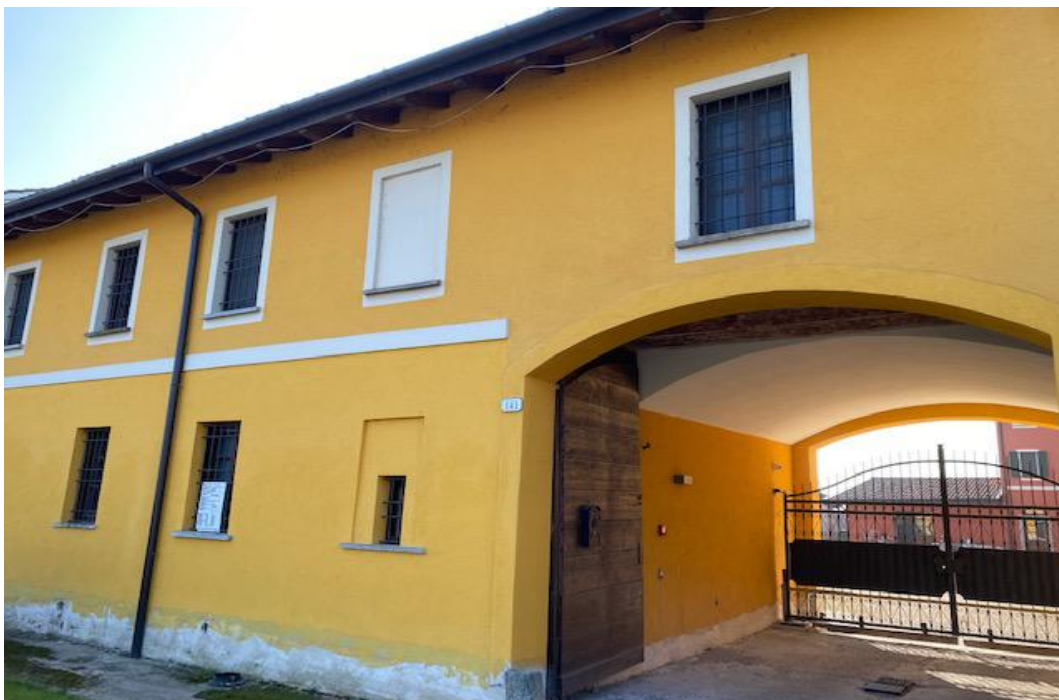
INGRESSO CASCINA SU VIA STRADA CASCINA DI SOPRA N. 141
