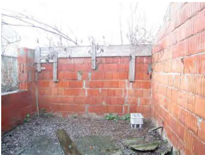
VISTA SPAZIO AL RUSTICO (non coperto)
