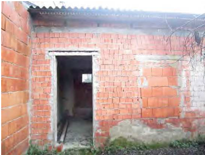
VISTA SPAZIO AL RUSTICO (non coperto)
