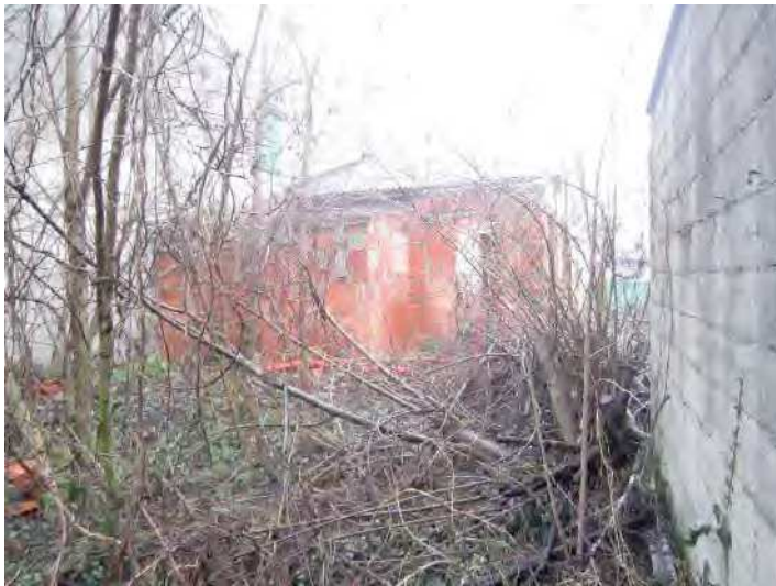
VISTA FRONTE NORD E AREA CORTILIZIA
