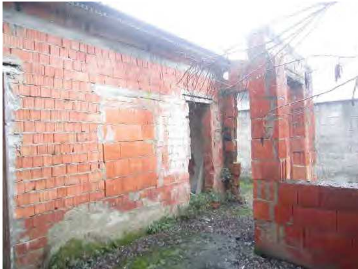
VISTA SPAZIO AL RUSTICO (non coperto)
