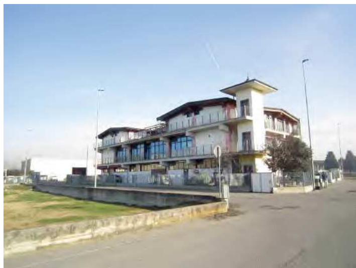
VISTA FRONTI SUD-OVEST DEL FABBRICATO A DESTINAZIONE ARTIGIANALE/PRODUTTIVA DA VIA STRADA PROVINCIALE 23
