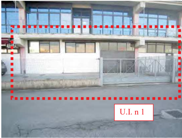
VISTA FRONTE OVEST DEL MAGAZZINO/DEPOSITO (U.I. N 1) DALLA VIA STRADA PROVINCIALE 23
