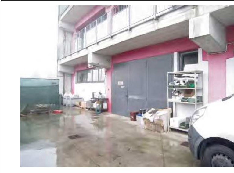
VISTA PROSPETTO NORD E INGRESSO AL MAGAZZINO
