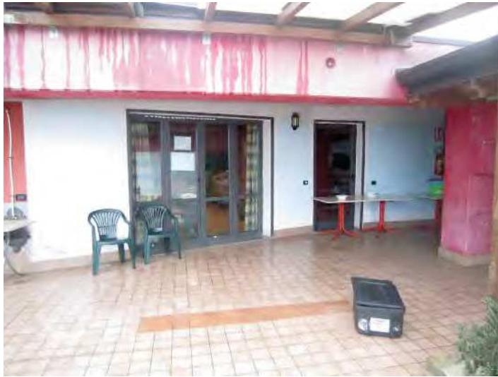
VISTA INGRESSO DALLA TERRAZZA COMUNE
