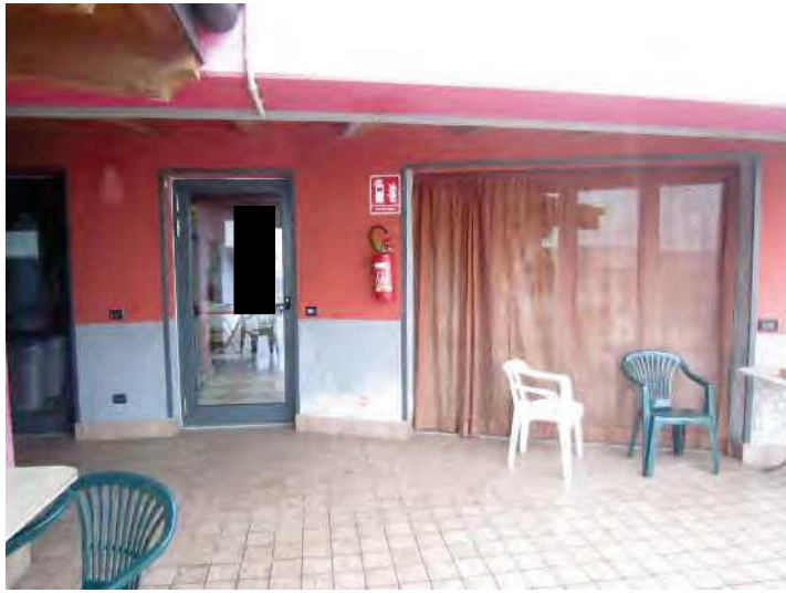
FOTO INGRESSO DALLA TERRAZZA COMUNE
