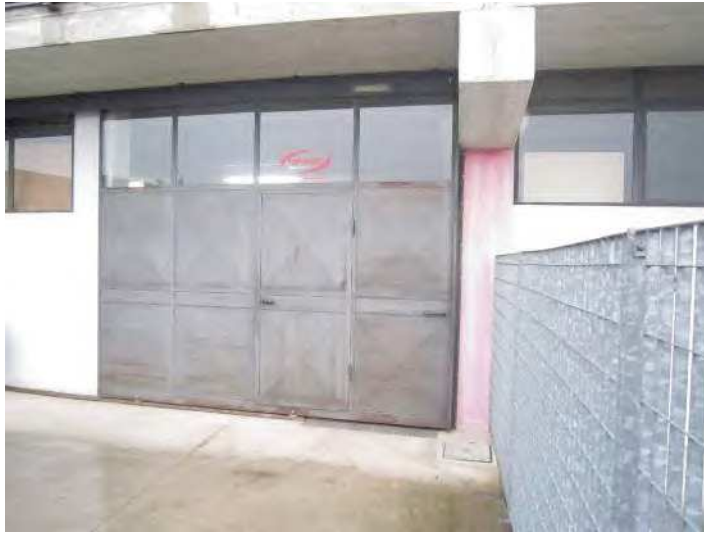
VISTA PORTA DI INGRESSO AL MAGAZZINO/DEPOSITO
