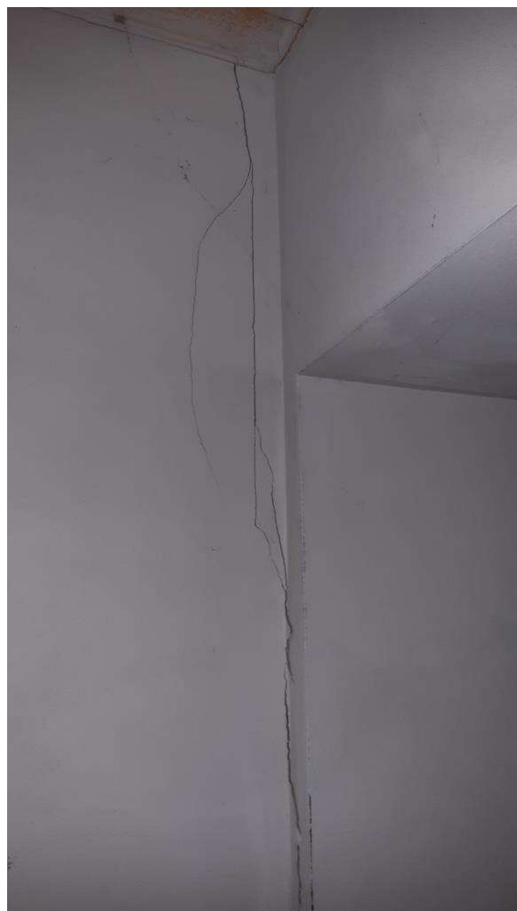
Piano Primo – Ripostiglio (2)
