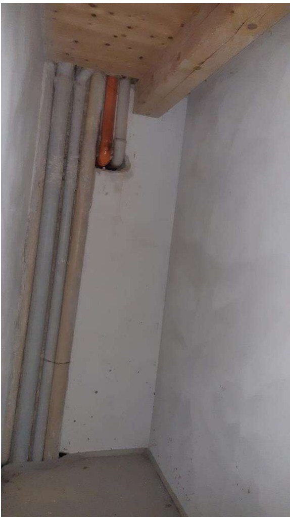
Piano Primo – Ripostiglio (2)
