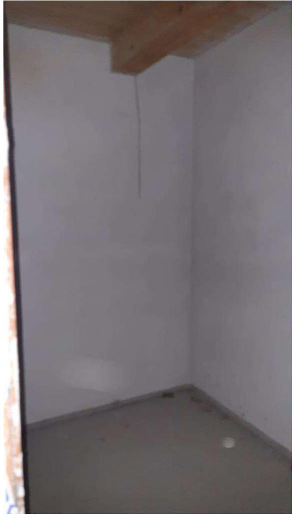
Piano Primo – Ripostiglio
