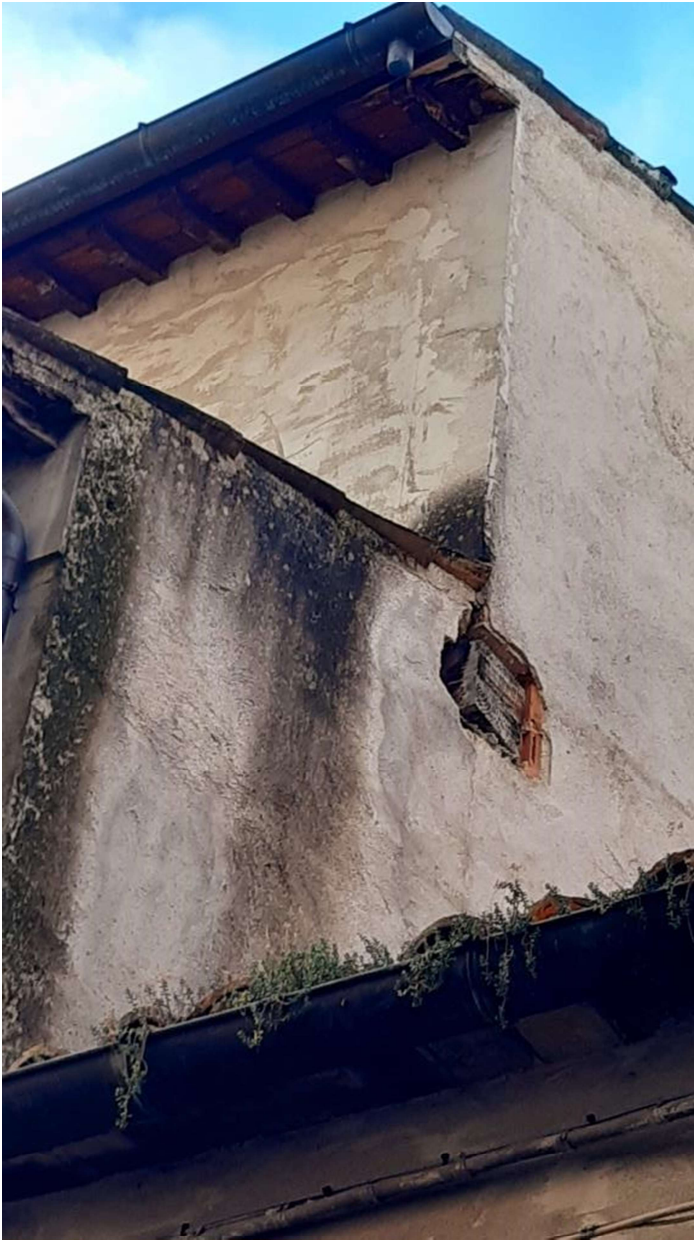
Esterno/Interno – Infiltrazioni dalla copertura
