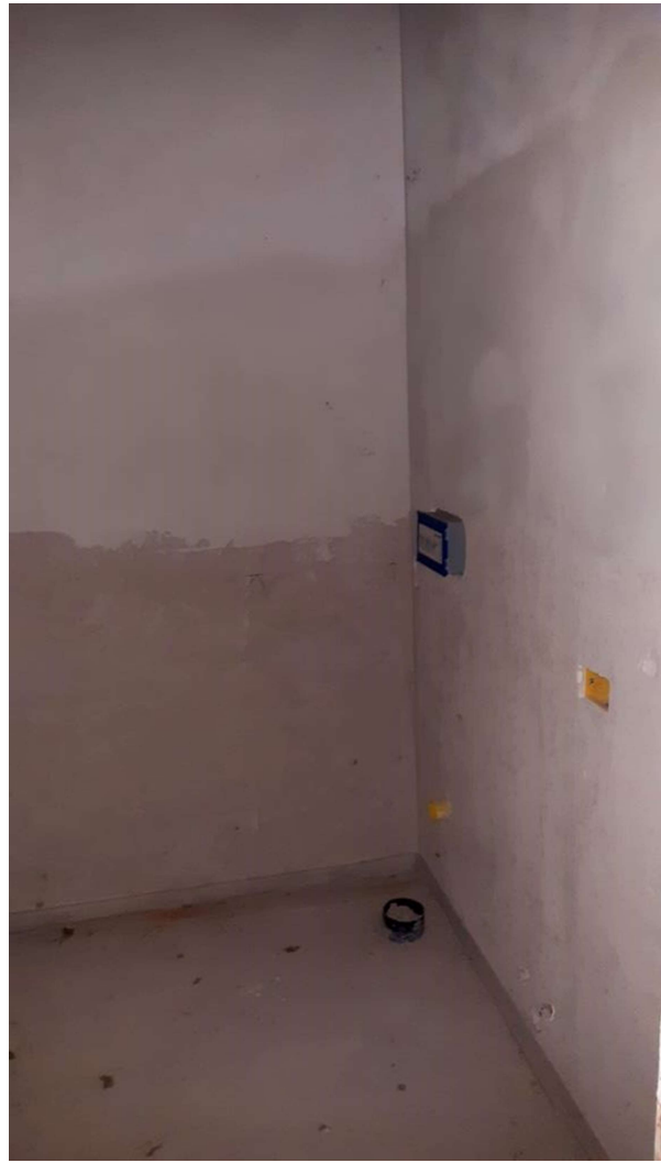
Piano Terzo – Bagno
