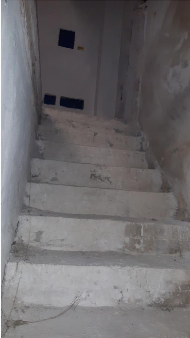
Piano Terra – Vano Scala
