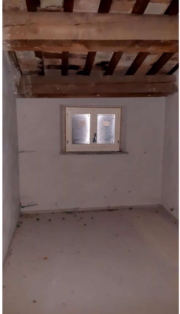
Piano Terzo – Ripostiglio
