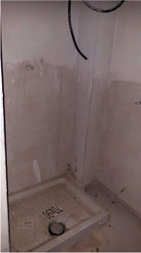
Piano Terzo – Bagno
