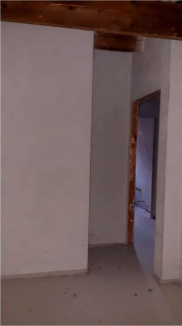
Piano Terzo – Ripostiglio
