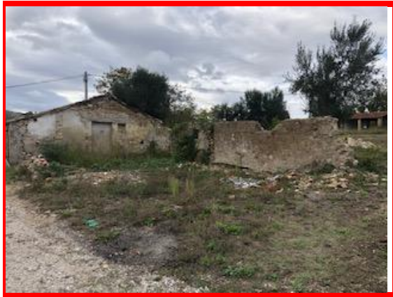
Foto 1 – Fabbricato crollante ed interamente demolito a seguito di evento sismico.
