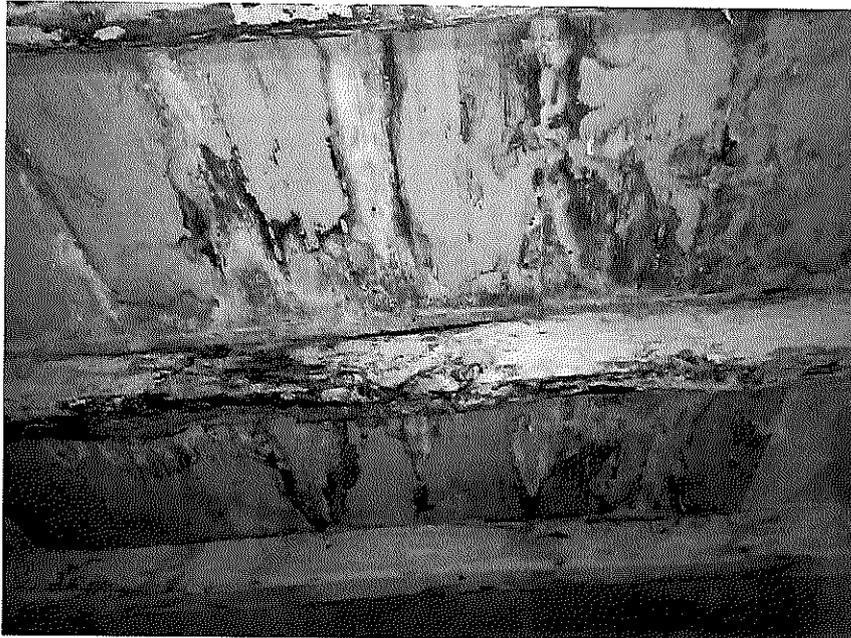
Dopo valutazione dei due preventivi depositati nel fascicolo telematico, si riscontra la sostituzione dell'orditura danneggiata e il ripasso del manto di copertura per l'intera falda volta a sud.
