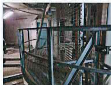
FOTO 23 - VISTA IMPIANTI, PERCORSI PEDONALI E PARAPETTI DI PROTEZIONE
