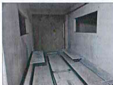
FOTO 22 - VISTA DELL'INTERNO DEL POSTO AUTO
