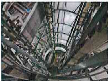
FOTO 25 - TREVI PARK VISTA DALL'ALTO DELL'AUTOSILO
