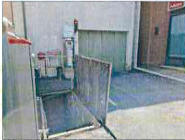
FOTO 13 - SCALA DI ACCESSO PER I TECNICI DELLA MANUTENZIONE
