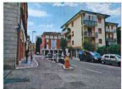
FOTO 03 - AUTOSILO TREVI PARK CORSIA D'ACCESSO CON SBARRA
