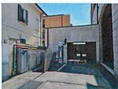
FOTO 11 - AREA DI PARCHEGGIO AUTOVETTURA PRE-MOVIMENTAZIONE
