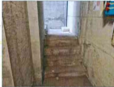
FOTO 14 - ACCESSO TECNICI MANUTENZIONE
