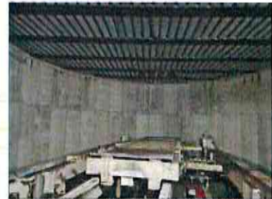
FOTO 15 - VISTA DEI MACCHINARI DEDICATI ALLA MOVIMENTAZIONE
