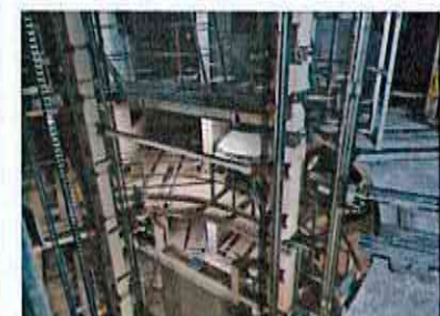
FOTO 24 - TREVI PARK VISTA DEI PIANI INTERRATI
