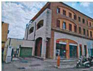
FOTO 02 - AUTOSILO TREVI PARK PORTONE DI ACCESSO
