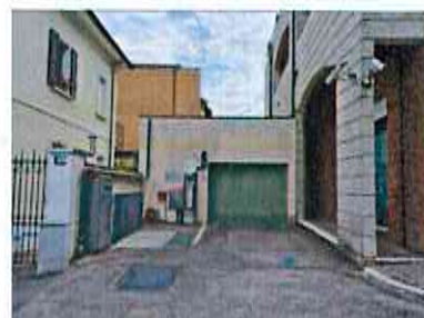
FOTO 09 - AUTOSILO TREVI PARK VISTA GENERALE DELL'INGRESSO
