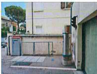
FOTO 07 - VISTA AREA ANTISTANTE AL PORTONE DI ACCESSO AUTOSILO
