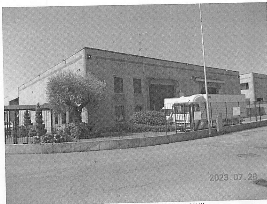
ESTERNO FRONTE NORD VIA DEGLI ARTIGIANI
