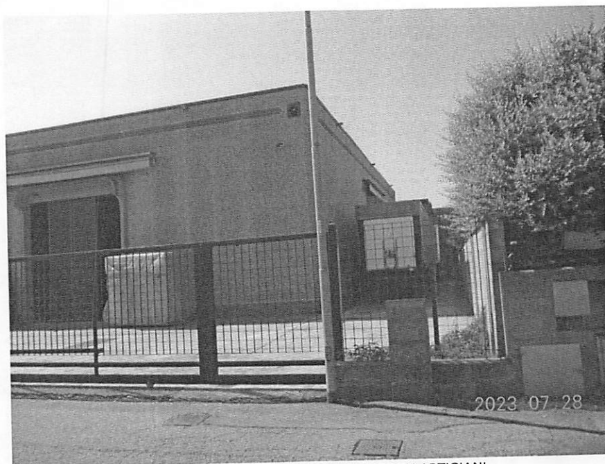
ESTERNO FRONTE NORD/OVEST VIA DEGLI ARTIGIANI
