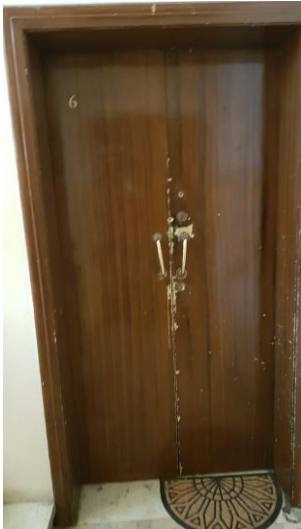
ACCESSO DA VANO SCALE
