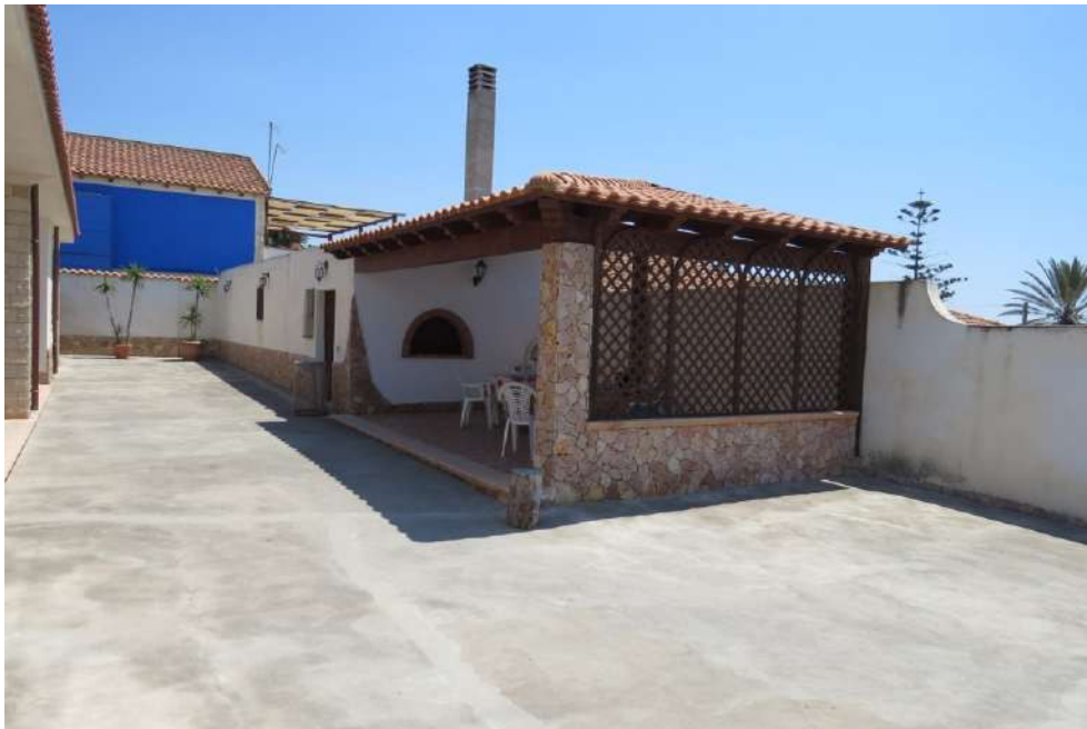
Foto n. 48 – Lotto 6, Tettoia e vano forno.
