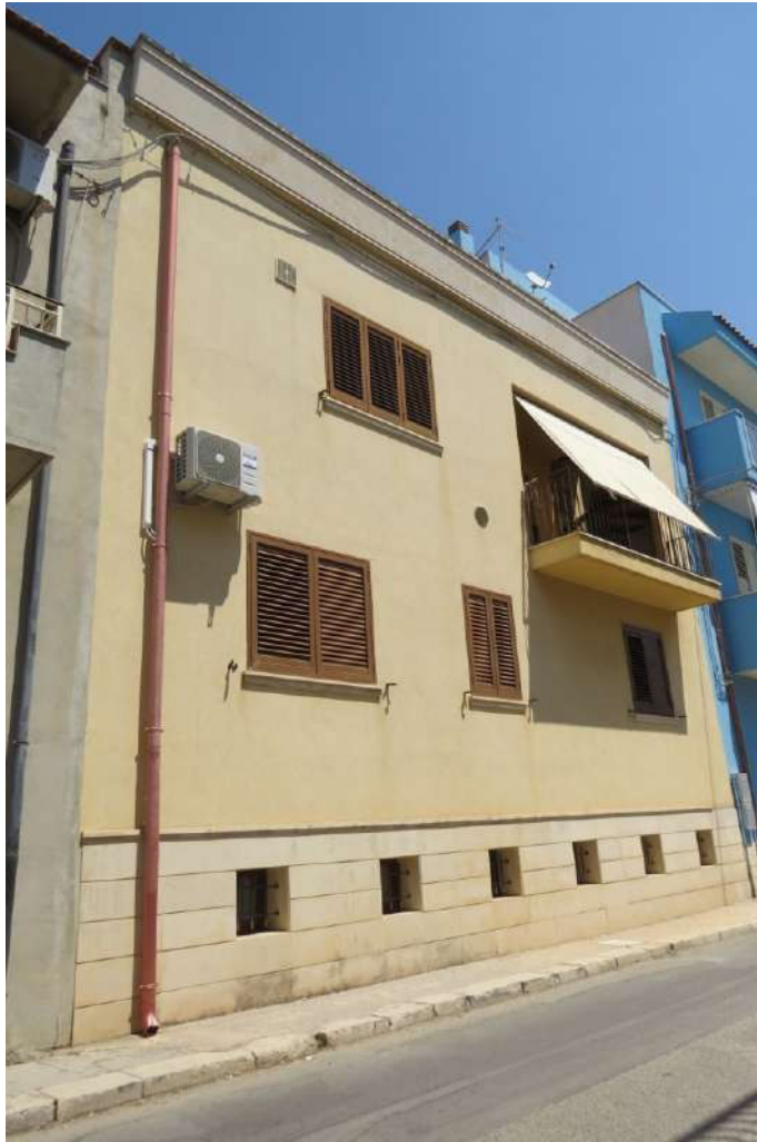
Foto n. 51 – Lotto 7, Edificio per civile abitazione.
