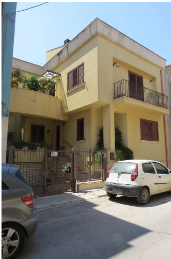
Foto n. 50 – Lotto 7, Edificio per civile abitazione
