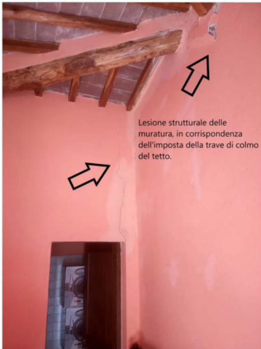
Particolare delle lesioni (interne e esterne) provocate dallo smottamento del terreno verso valle
