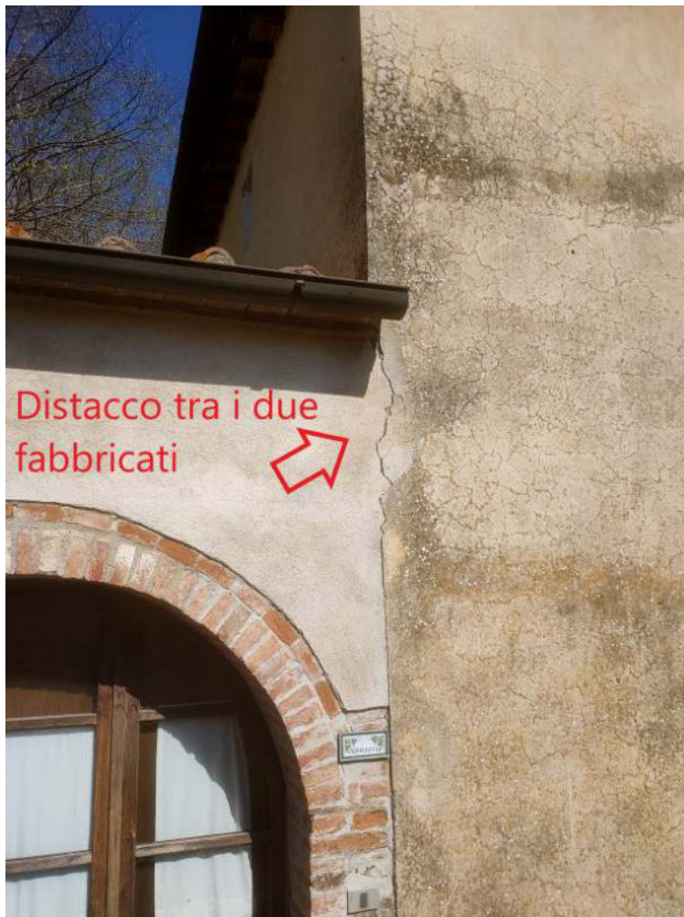
Particolare delle lesioni (interne e esterne) provocate dallo smottamento del terreno verso valle
