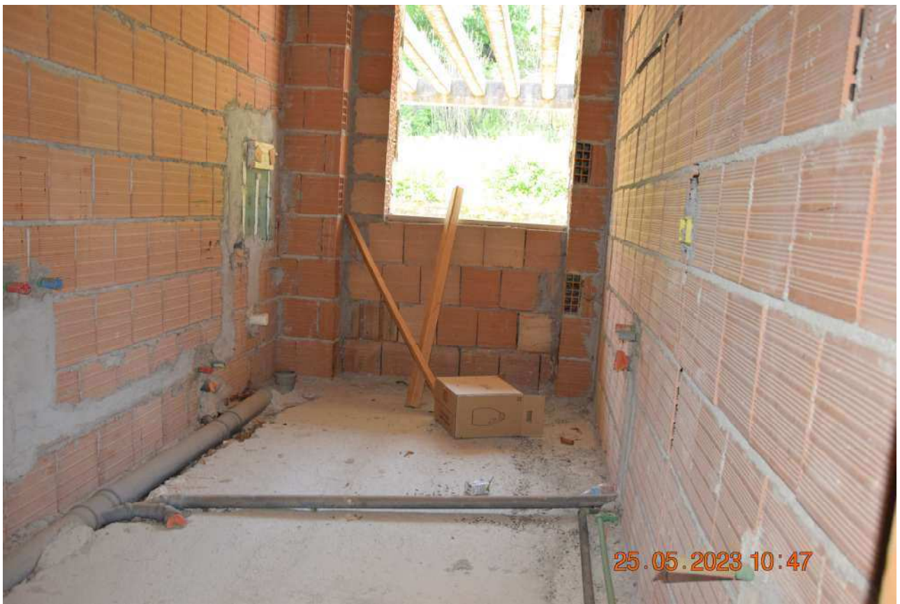
Foto n. 2 Interna Piano Seminterrato – Deposito Olio
