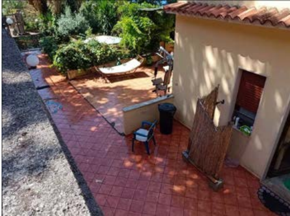
Foto n. 5 – Esterno fabbricato lato Est
