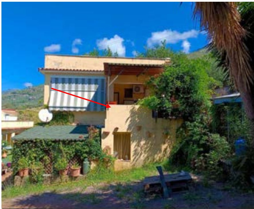
Foto n. 3 – Esterno fabbricato lato Ovest
