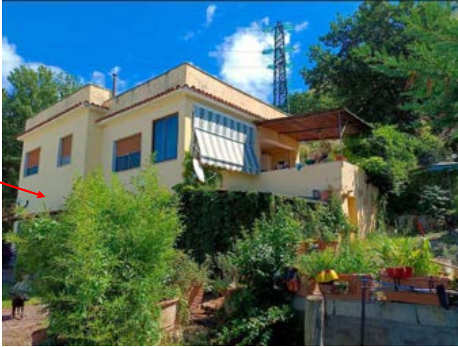
Foto n. 2 – Esterno fabbricato lato Ovest
