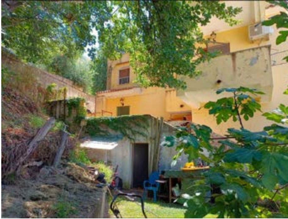
Foto n. 4 – Esterno fabbricato lato Nord
