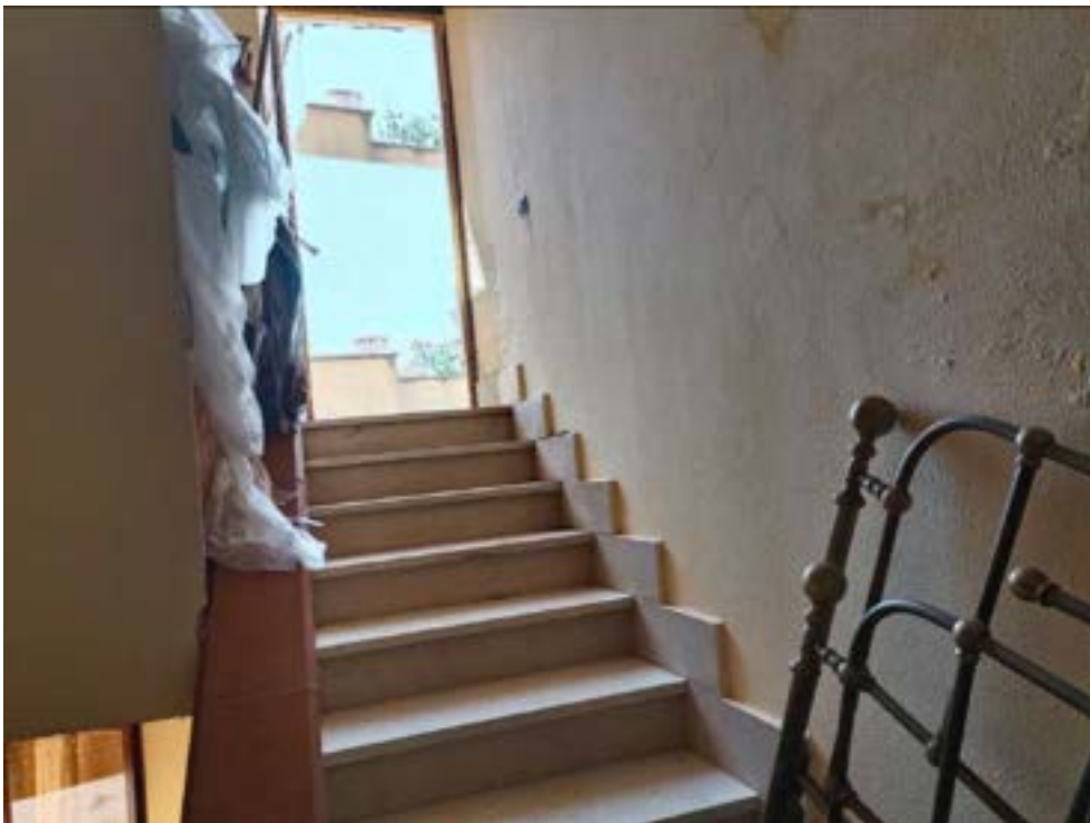
Foto n. 8 – Scala di accesso al lastrico solare
