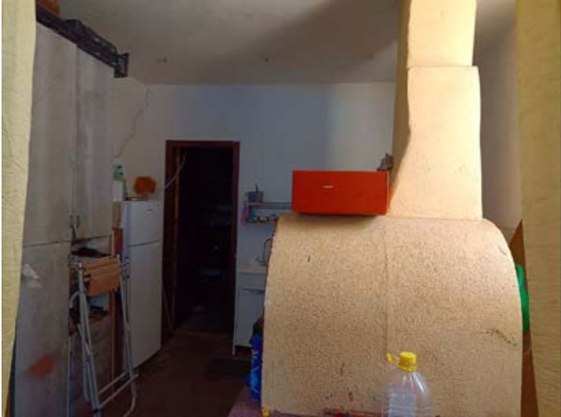
Foto n. 26 – Portico piano terra oggetto di condono edilizio del 10.12.2004 prot. 14237
