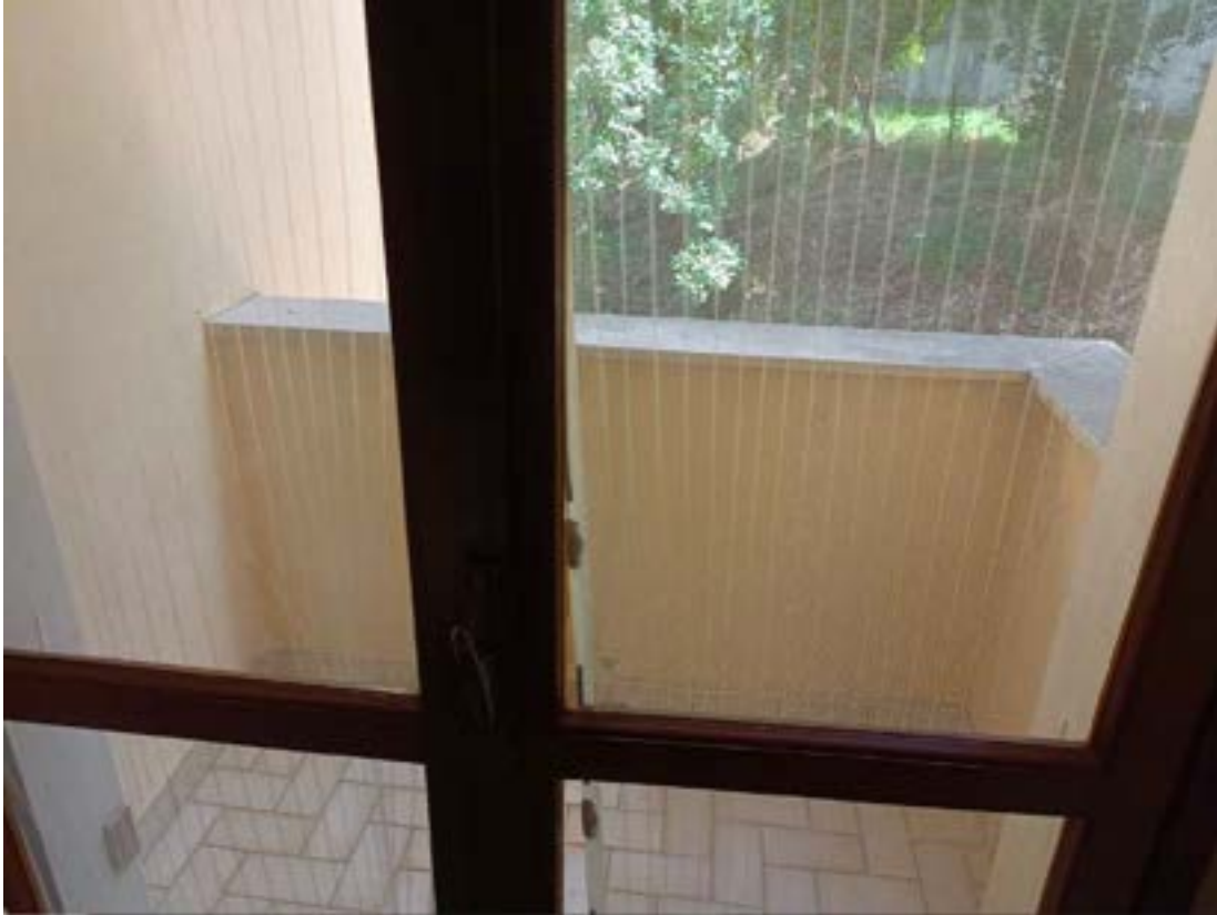
Foto n. 16 - Balcone piano primo
