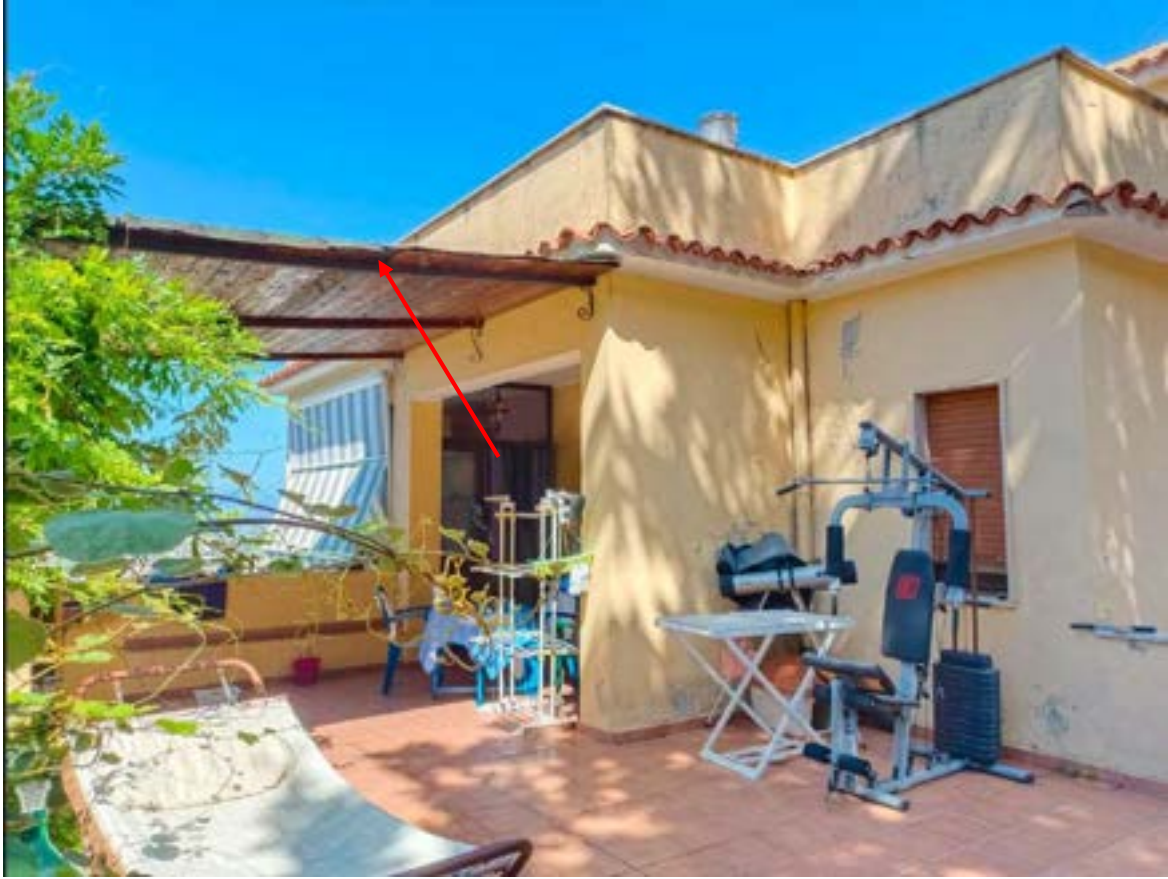
Foto n. 27 – Portico-tettoia piano primo Abusiva
