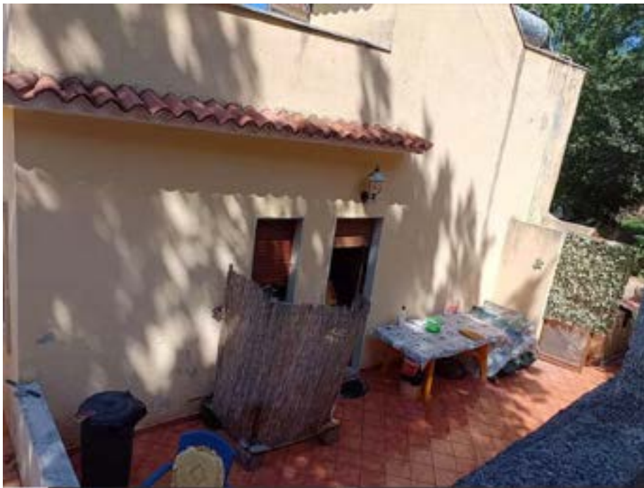
Foto n. 5 – Esterno fabbricato lato Est
