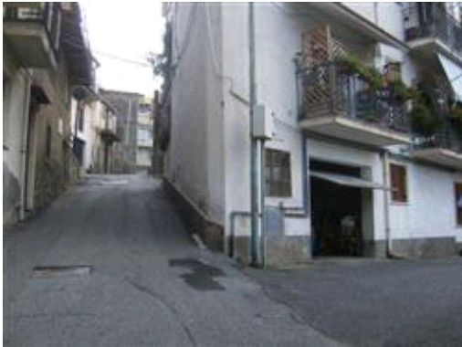
Ingresso cantina - foto 01
