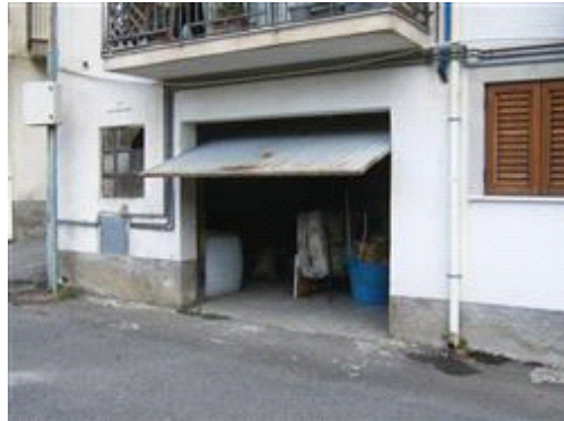
Ingresso cantina - foto 02
