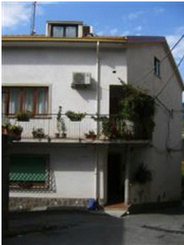
Vista fabbricato con ingresso sulla via Romagna
