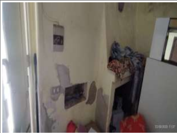
Foto 3 vano piano terra
